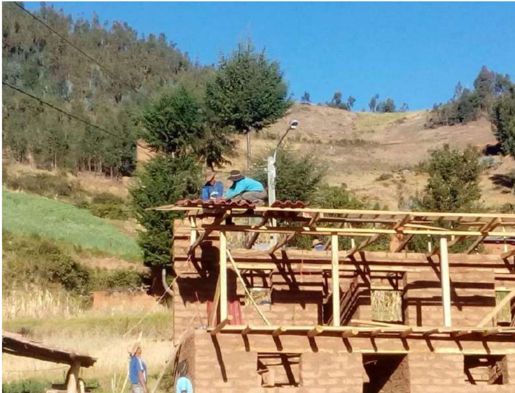
Figura 154. Colocación de cobertura tejaforte sobre tijerales. Fuente: Toma propia.
