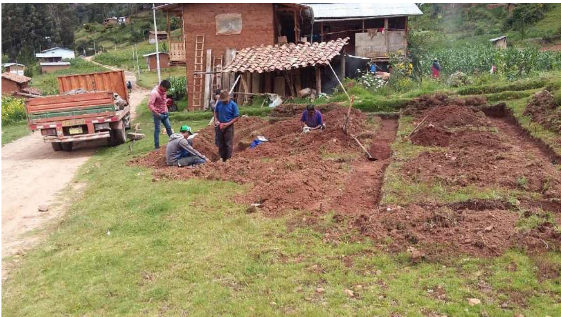
Figura 156: Excavación manual de cimientos. Fuente: Toma propia.
