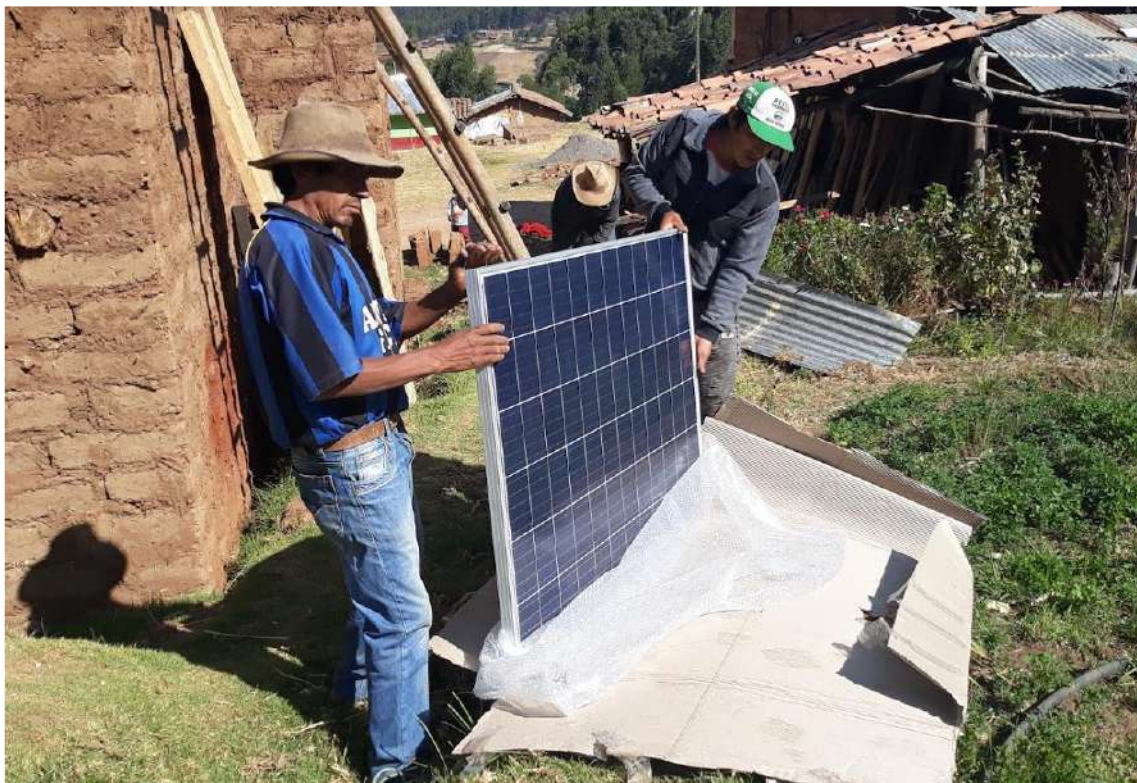
Figura 168. Traslado y Colocación de panel solar. Fuente: Toma propia.
