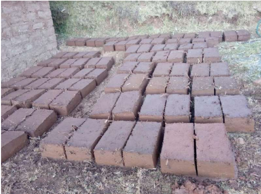
Figura 156. Elaboración nuevos adobes para el baño, estos tienen dimensiones más pequeñas. Fuente: Toma propia.
