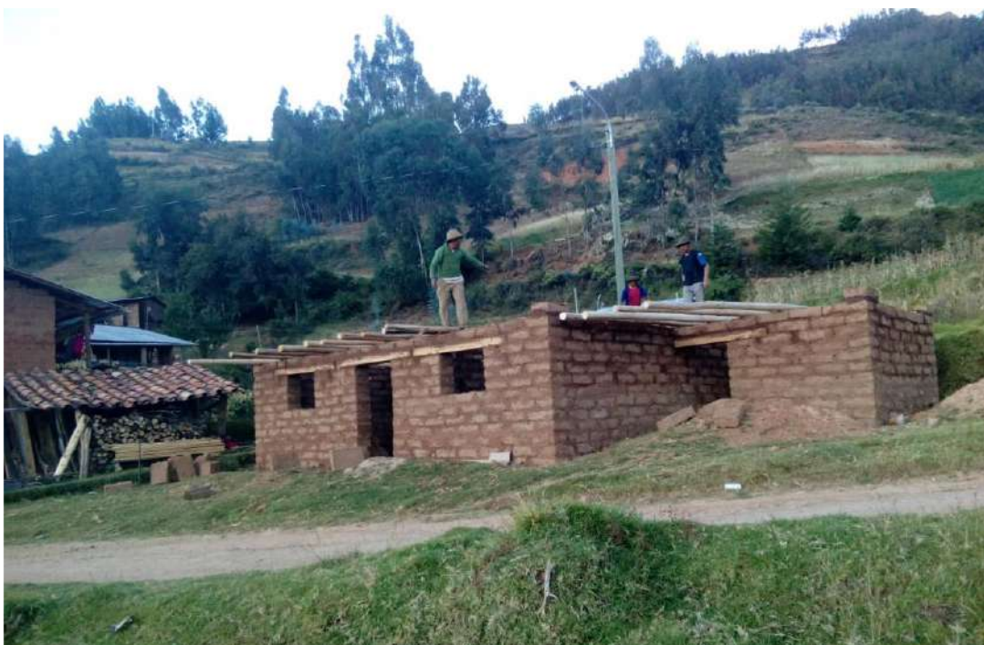
Figura 148. Colocación de vigas de eucalipto para techo. Fuente: Toma propia.
