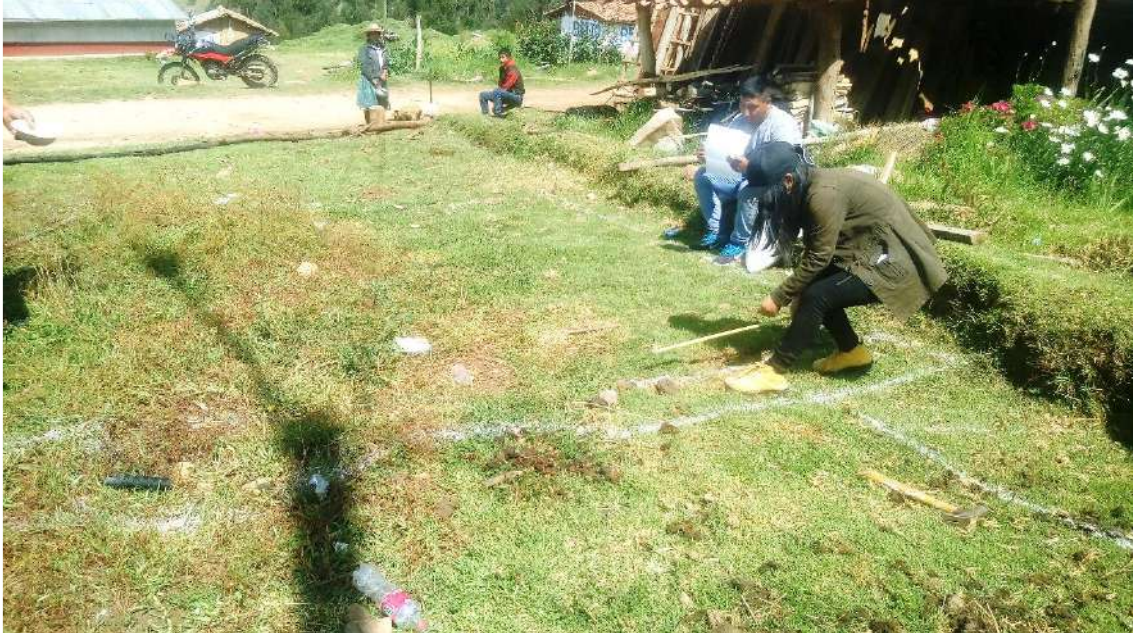
Figura 143. Trazo y replanteo de los planos. Fuente: Toma propia.
