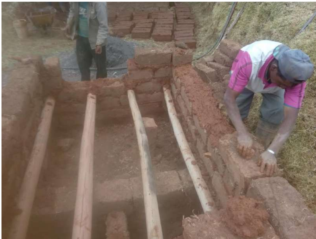
Figura 158. Colocación de vigas para piso de baño y cámara Compostera. Fuente: Toma propia.
