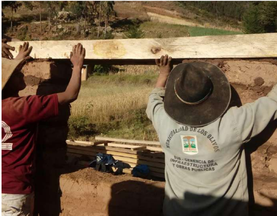
Figura 147. Colocación de dinteles para ventanas y puertas. Fuente: Toma propia.
