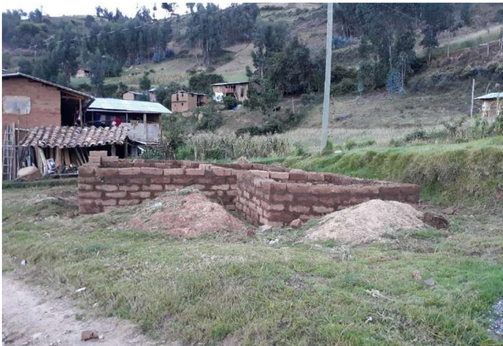
Figura 146. Levantamiento de muro, 7° hilada. Fuente: Toma propia.
