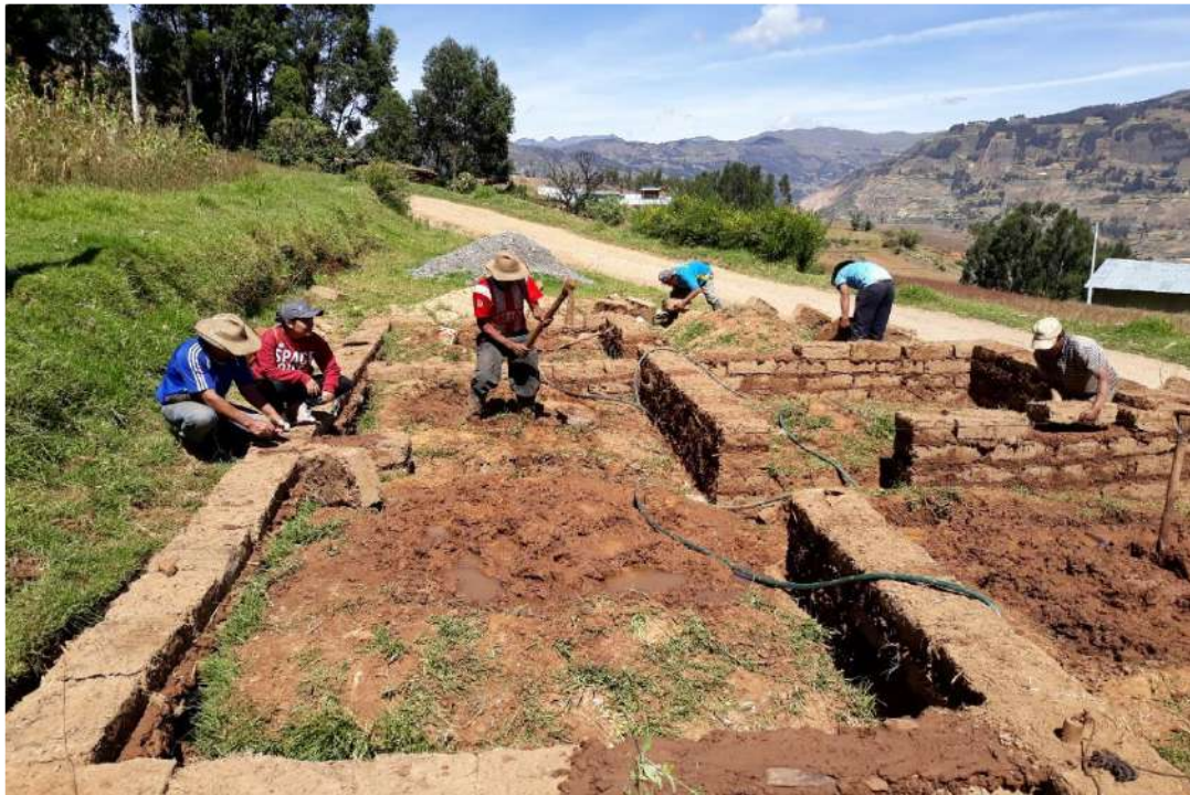
Figura 145. Chequeo del levantamiento de muro y colocación de los adobes. Fuente: Toma propia.
