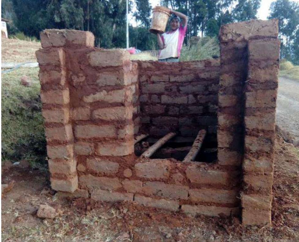
Figura 161. Levantamiento de muro de baño. Fuente: Toma propia.
