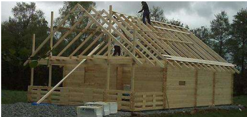
Figura 31. Estructura en entramado de madera.
