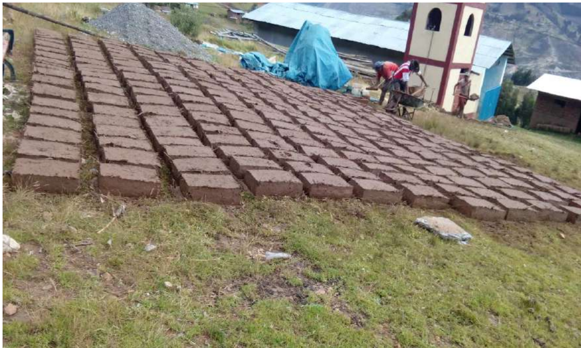
Figura 136. Colocación de los adobes para secarse al sol. Fuente: Toma propia.
