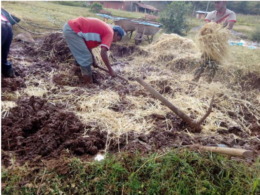
Figura 134. Mezcla de barro y paja para la elaboración de los adobes. Fuente: Toma propia.
