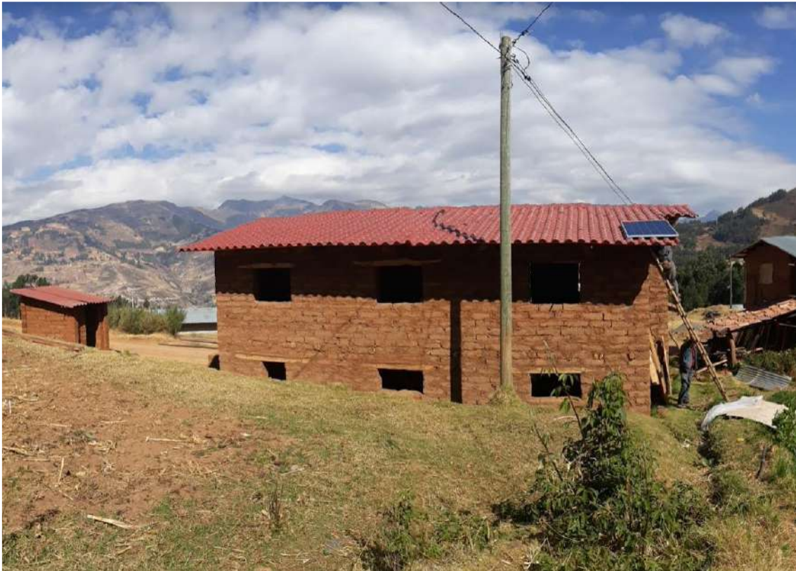
Figura 169. Vista de panel en la parte trasera del tejado de la casa. Fuente: Toma propia.
