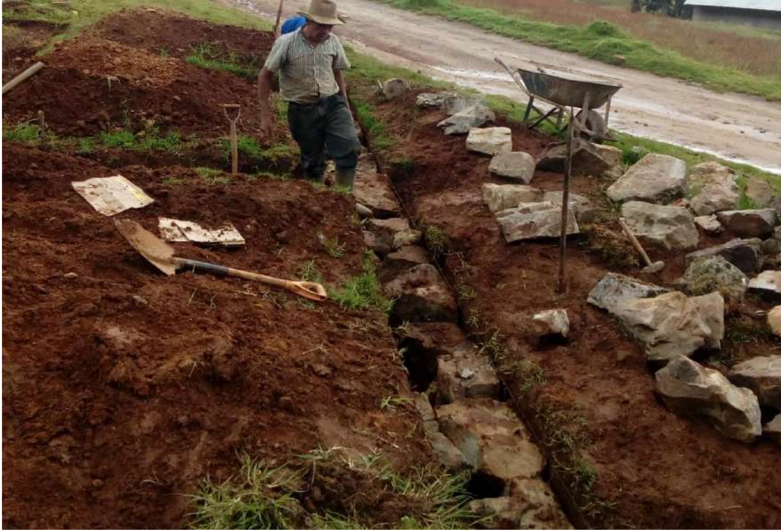
Figura157. Colocación de Piedra base para el vaciado de base. Fuente: Toma propia.
