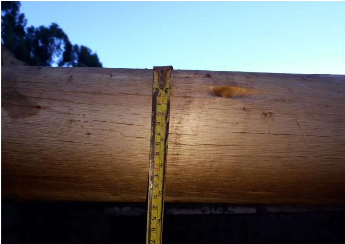
Figura 150. Verificación del diámetro de las vigas para techo. Fuente: Toma propia.
