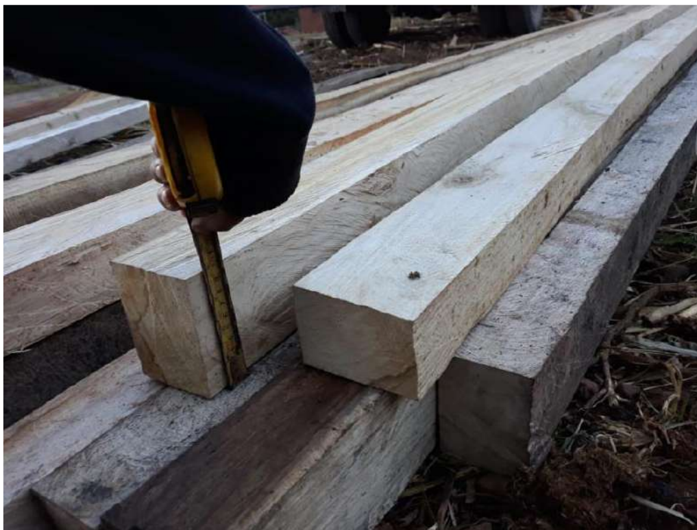
Figura 143. Verificación de las medidas de los dinteles. Fuente: Toma propia.
