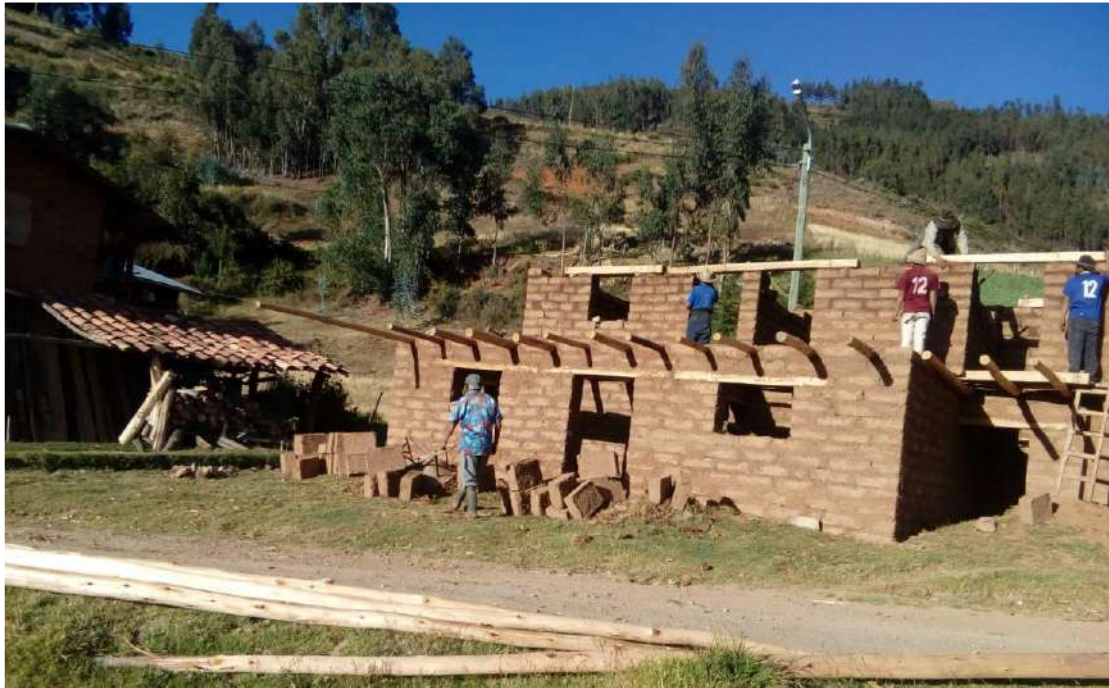
Figura 153. Levantamiento de segundo nivel, colocación de dinteles. Fuente: Toma propia.
