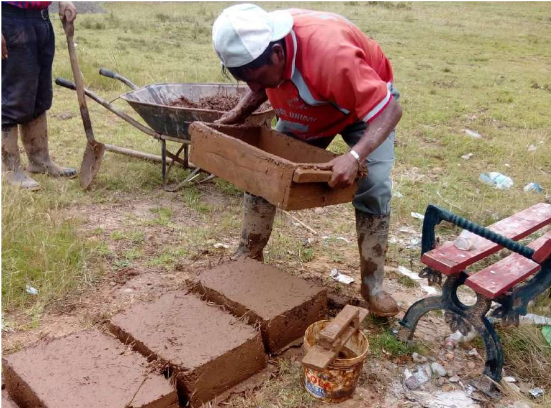
Figura 135. Colocación de la mezcla en los moldes de medidas 15cmx30cmx45cm. Fuente: Toma propia.
