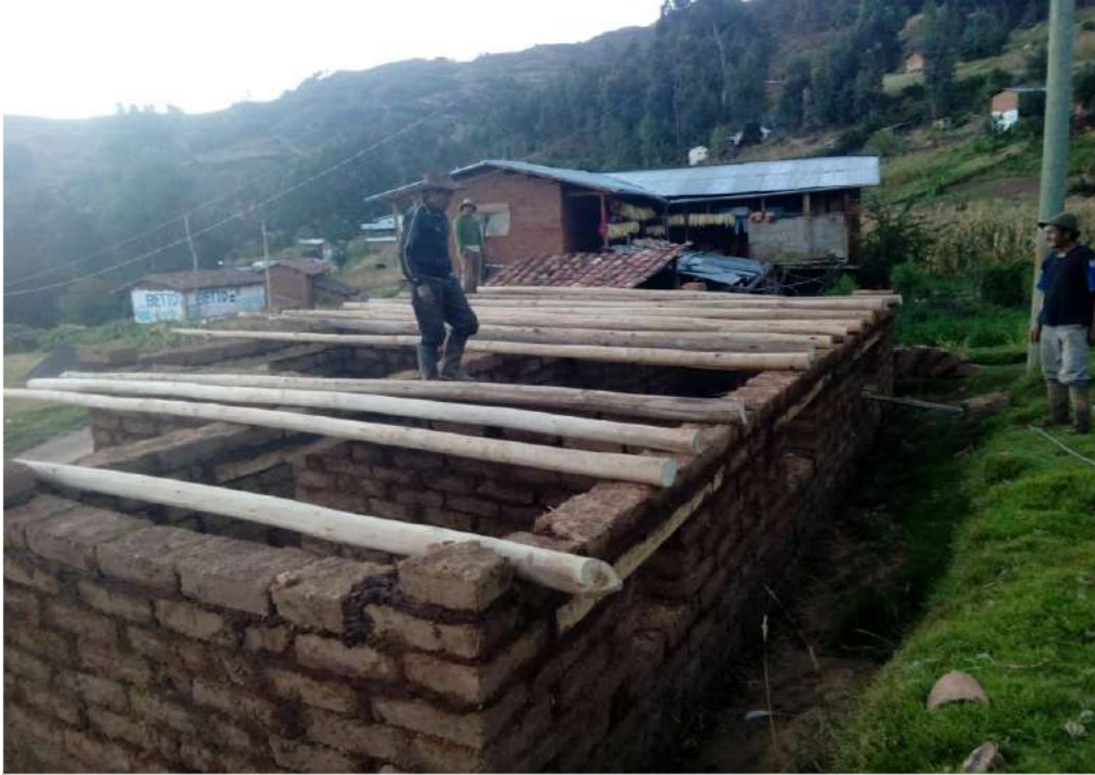
Figura 149. Disposición de vigas y selección del lugar de colocación. Fuente: Toma Propia.
