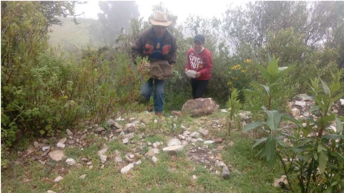
Figura 139. Selección de rocas para cimiento de la carretera y alrededor. Fuente: Toma propia.
