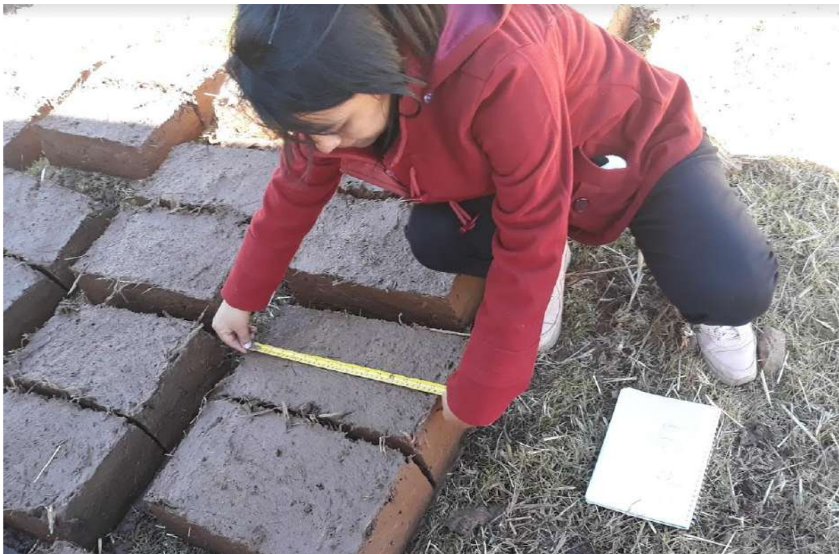
Figura 172. Se corroboran las medidas de los adobes para el baño son de 0.20x0.30x.015m. Fuente: Toma propia.
