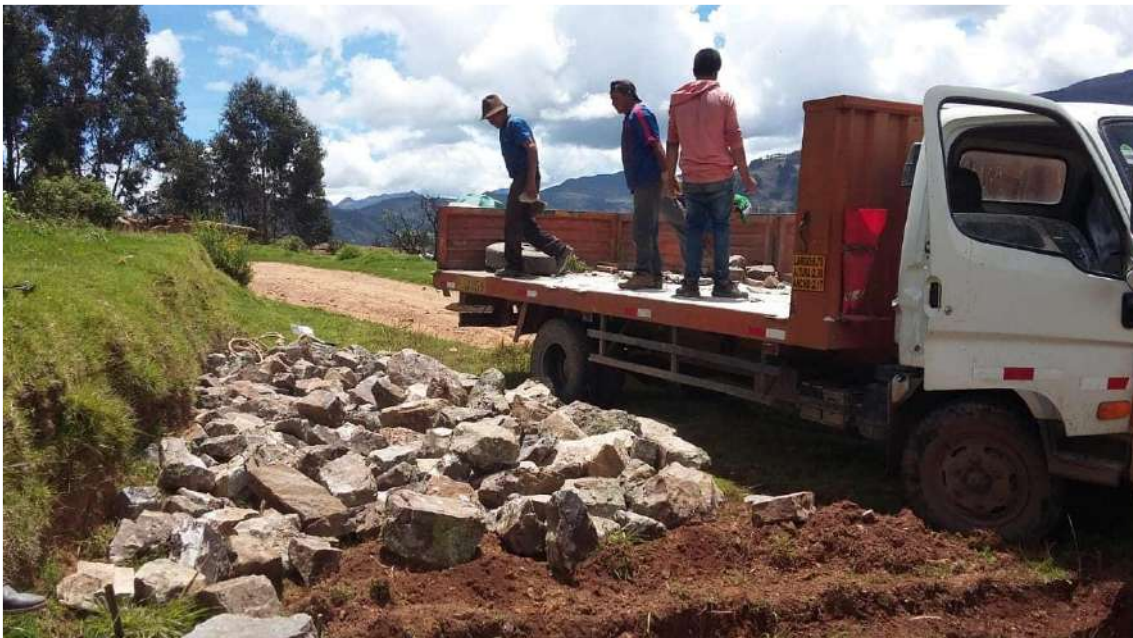
Figura 140. Traslado y colocación de piedra del lugar base para proyecto. Fuente: Toma propia.
