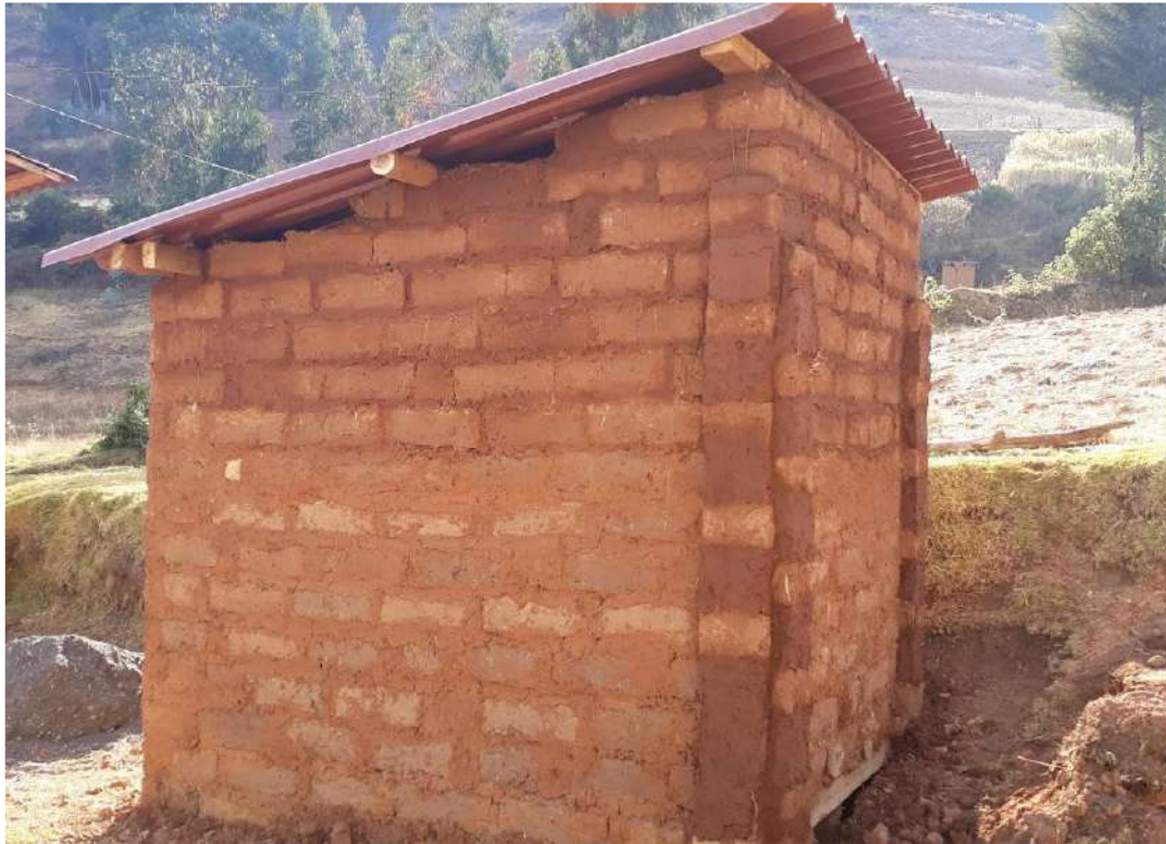
Figura 163. Vista lateral de baño seco. Fuente: Toma propia.
