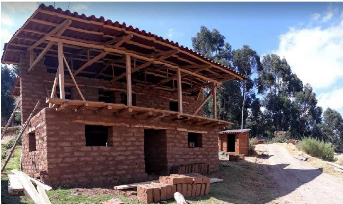
Figura 68. Vista general del prototipo. Fuente: Toma propia.
