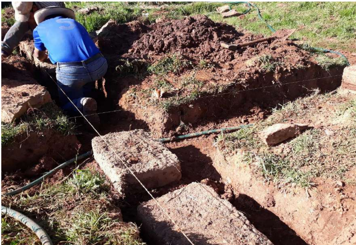
Figura 144. Levantamiento de pared y el alineamiento de los adobes. Fuente: Toma propia.
