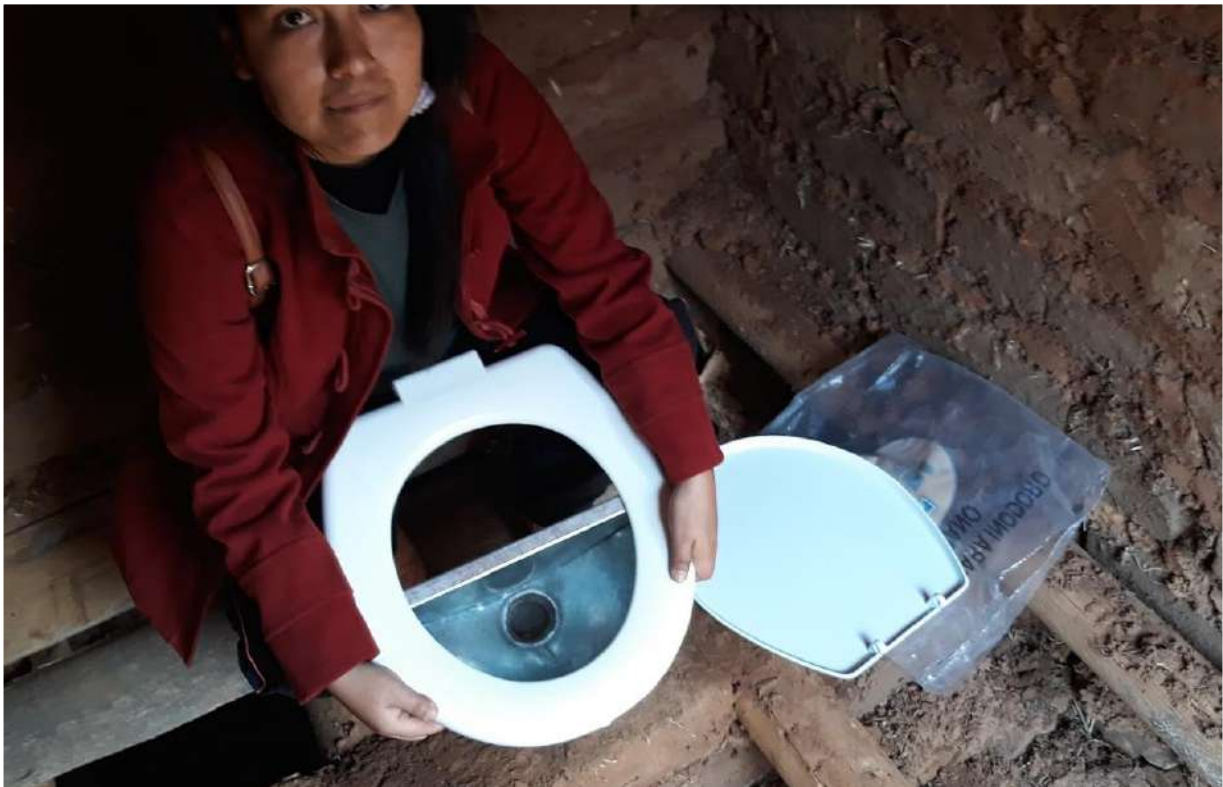
Figura 160. Colocación de vigas para piso de baño y cámara Compostera. Fuente: Toma propia.
