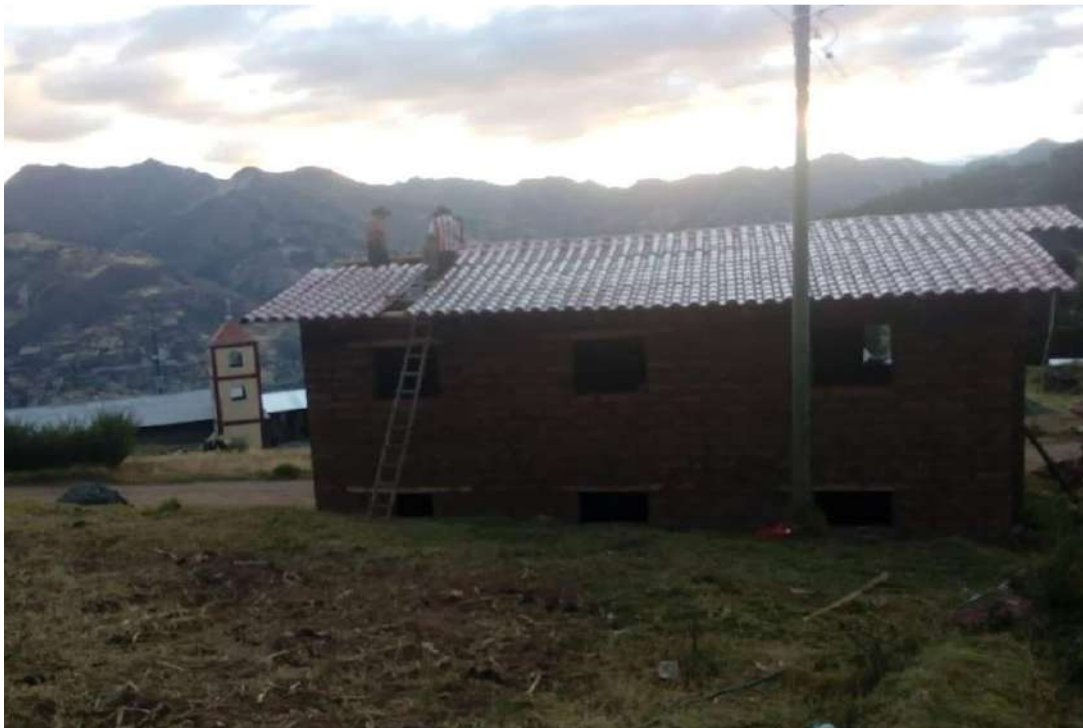
Figura 155. Culminación de la colocación de tejaforte como techo. Fuente: Toma propia.
