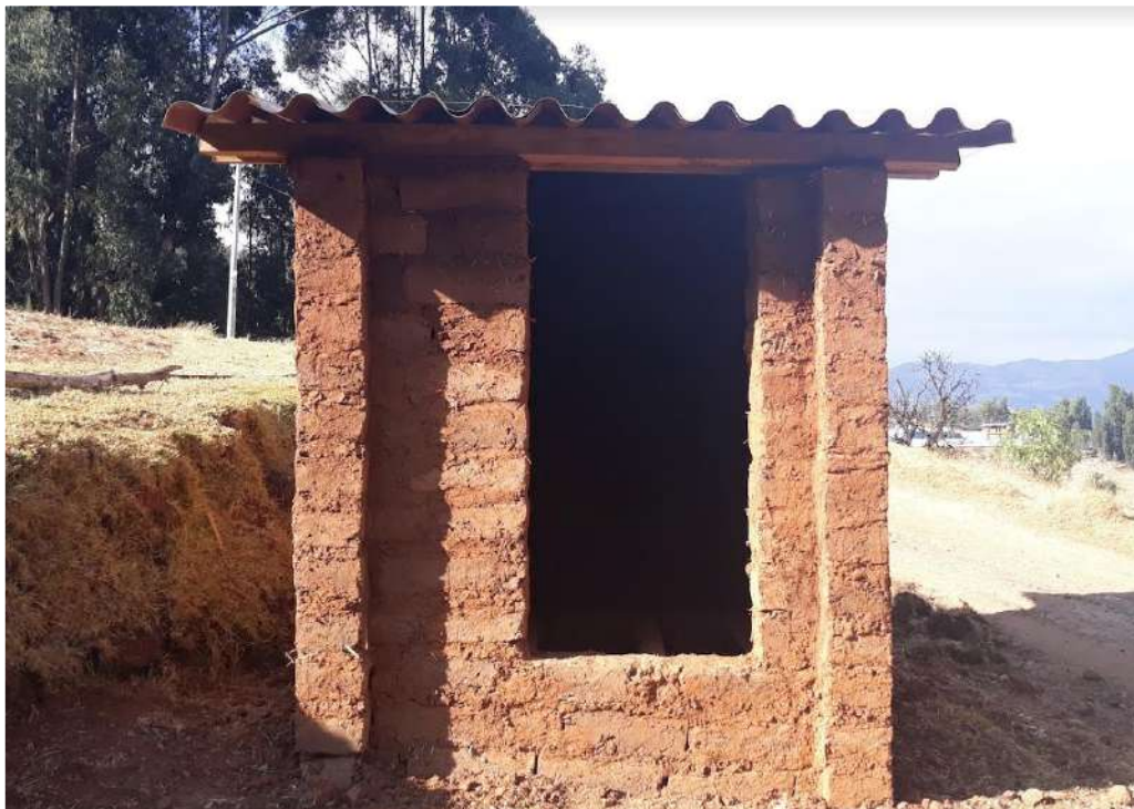
Figura 162. Vista frontal de baño seco. Fuente: Toma propia.
