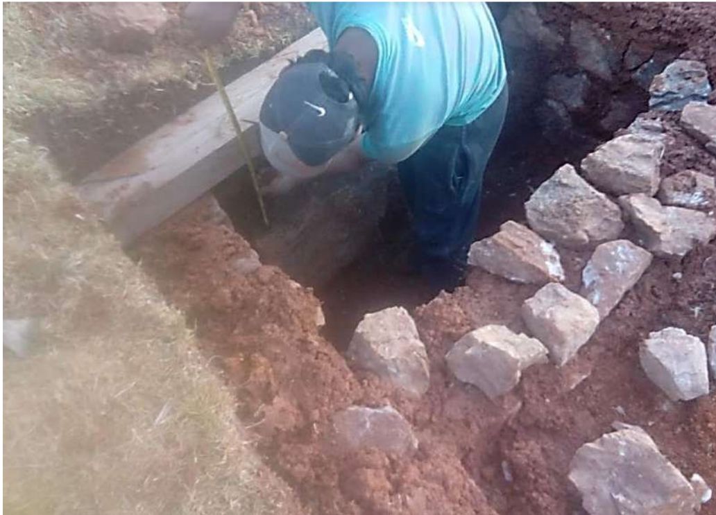
Figura 157. Vaciado de los cimientos ara baño y cámara Compostera. Fuente: Toma propia.
