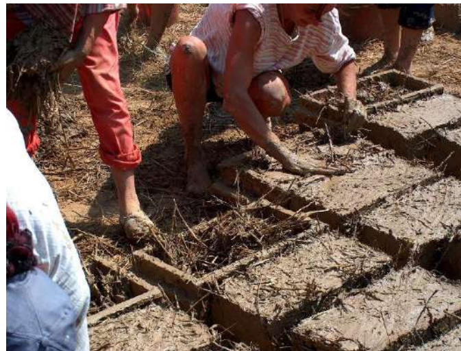
Figura 13. Colocación de barro para adobe en los moldes.
