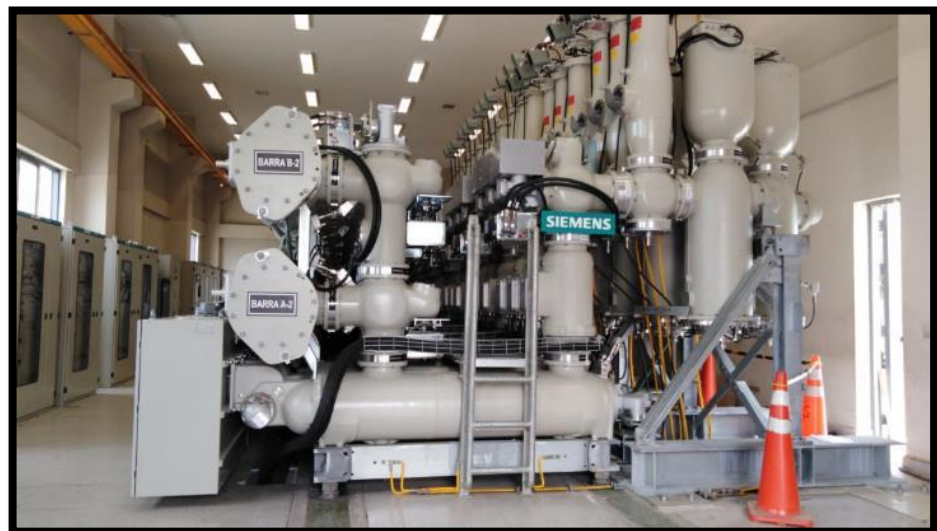
Figura N° 03: Subestación GIS
