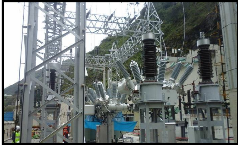
Figura N° 04: Subestación Híbrida
