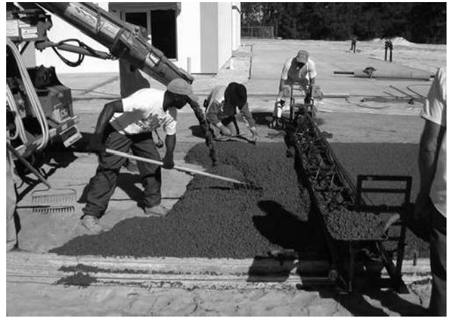
Fig. 8.5-El uso de enrasadora vibratoria para enrasado de concreto permeable.
