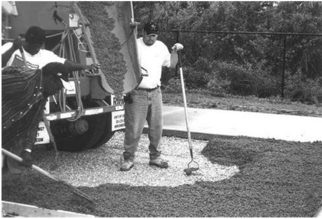
Fig. 8.1-Colocación de concreto permeable por de descarga trasera camión mezclador.
