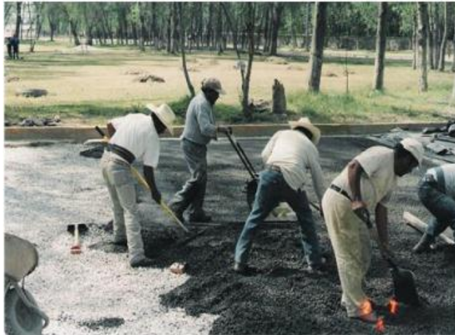
Figura 14. Colocación de pavimento permeable Fuente: Saucedo, (2010)
