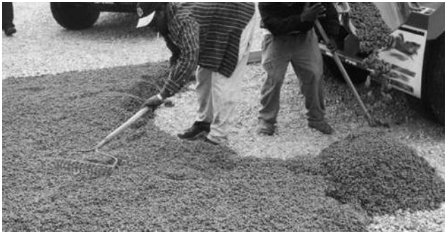
Fig. 8.3-Rastrillo concreto permeable a la elevación aproximada.
