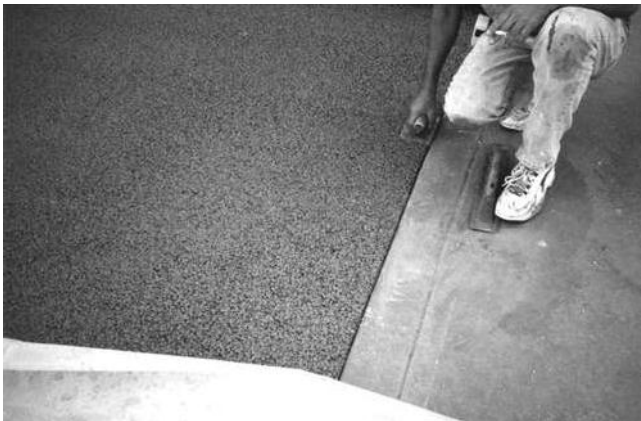
Fig. 8.10-reborde de hormigón permeable para mejorar la apariencia de las esquinas.
