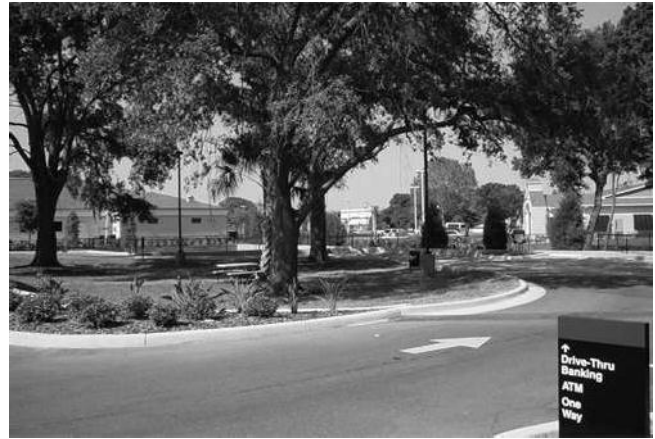
Fig. Pavimento de hormigón 3,2-permeable se utiliza dentro de la línea de goteo de árbol.
