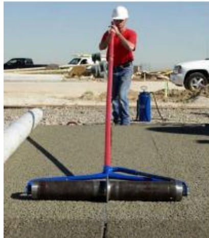
Figura 17. Realización de una junta constructiva en el concreto Fuente: López, (2010)
