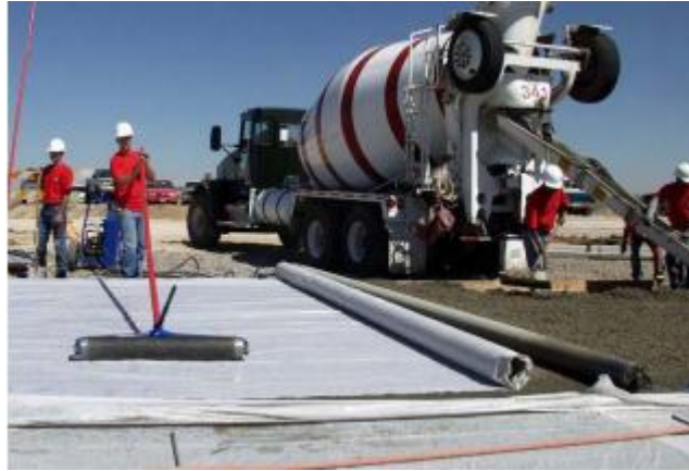
Figura 19. Curado del concreto permeable utilizando polietileno saturado. Fuente: Lopez, (2010)
