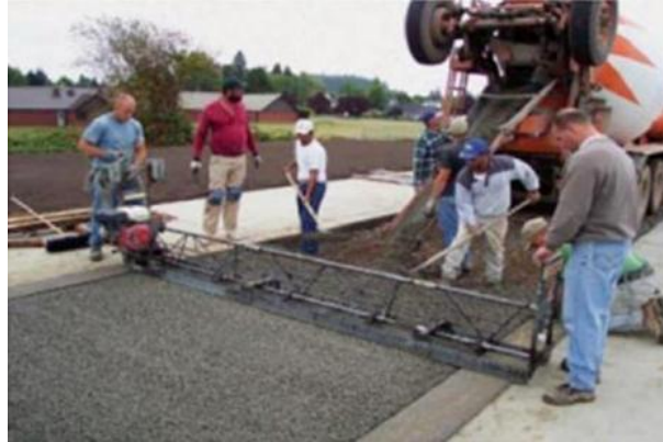
Figura 15. Enrasado del concreto permeable mediante el uso de una enrasadora vibratoria de marco con sección A.
