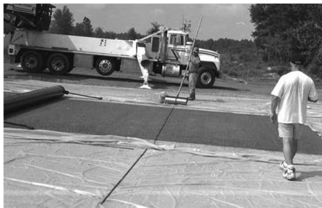
Fig. 8.14-Ejemplo de uso de barras de refuerzo para mantener hacia abajo el material curado.
