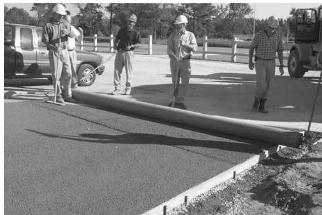
Fig. 8.7-Ejemplo de compactación de hormigón permeable por laminación.
