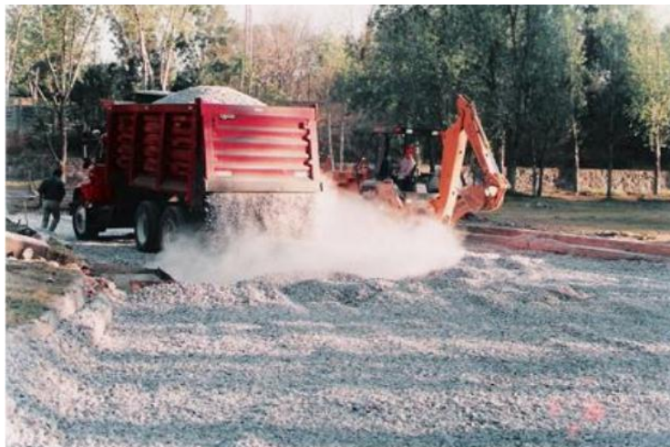
Figura 13. Base y subbase del pavimento permeable Fuente: Saucedo, (2010)
