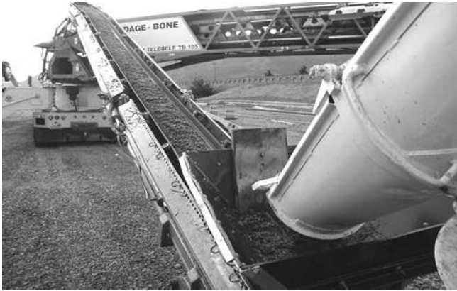
Fig. 8.2-Uso del transportador para colocar concreto permeable.
