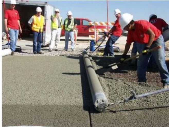
Figura 16. Compactación del concreto permeable por medio de un rodillo de acero Fuente: López, (2010)
