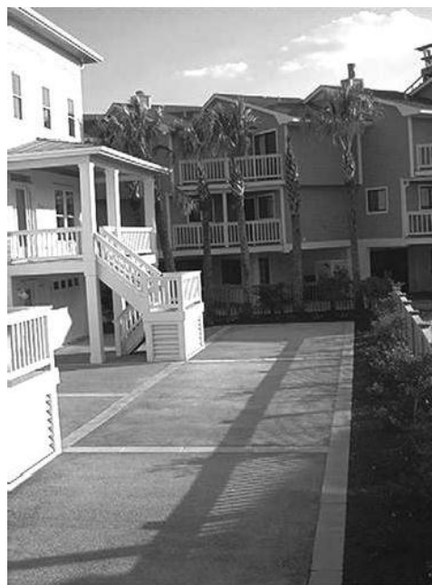
Fig. 3.1 montón de estacionamiento construido con pavimento de concreto permeable.
