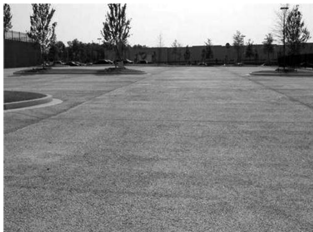
Fig. 12.3 permeable estacionamiento de hormigón.
