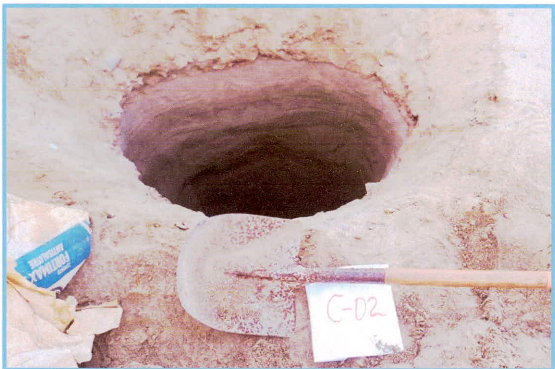
Foto N° 08 Excavación de la calicata "C2 – M2"
