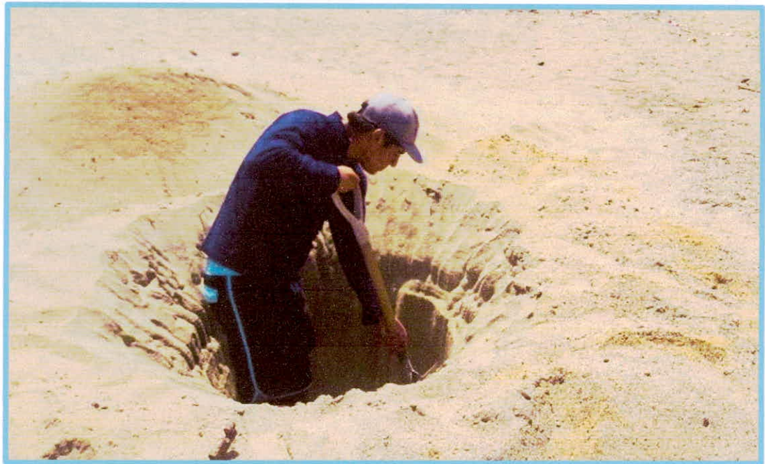
Foto N° 07 Excavación de calicata "C2 – M1"
