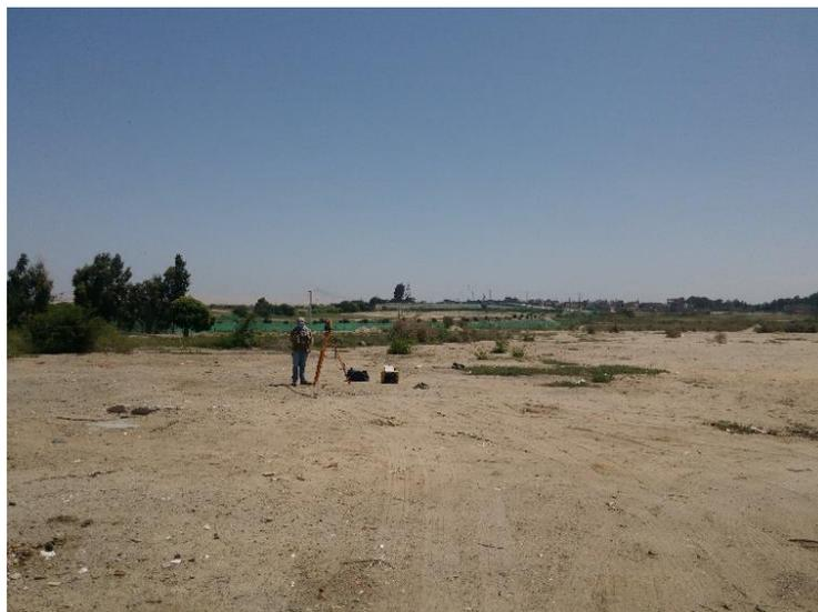
FOTO 06.- LEVANTAMIENTO TOPOGRAFICO CON ESTACION TOTAL
