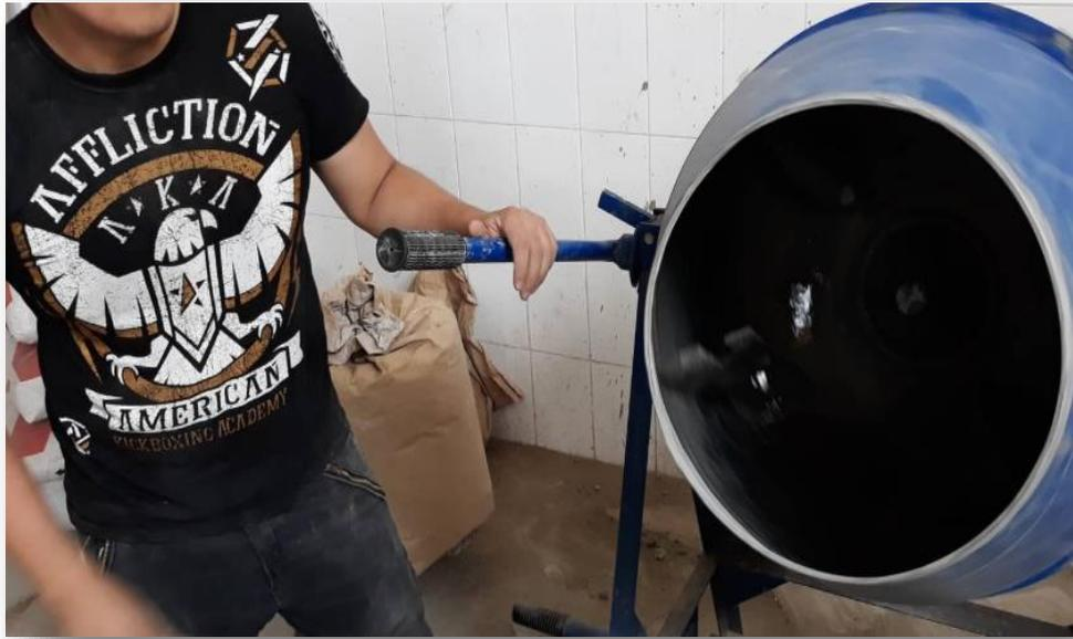
SATURANDO EL TROMPO ANTES DE AÑADIR LOS AGREGADOS.
