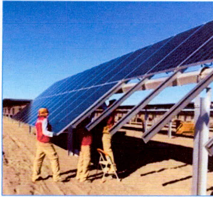
Figura N° 18 Montaje de "Paneles FV Central Fotovoltaica RUBI de 144 MW
