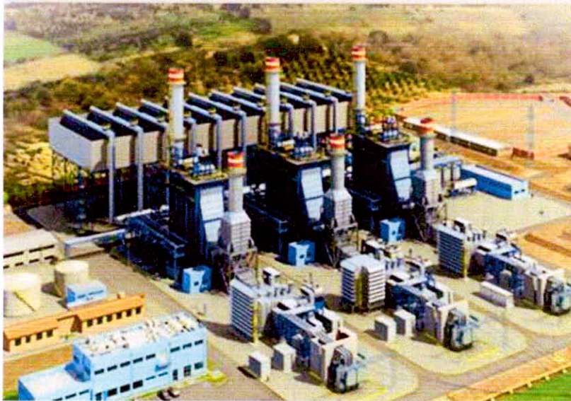
Figura N° 17 Central Termoeléctrica Ciclo Combinado de KALLPA
