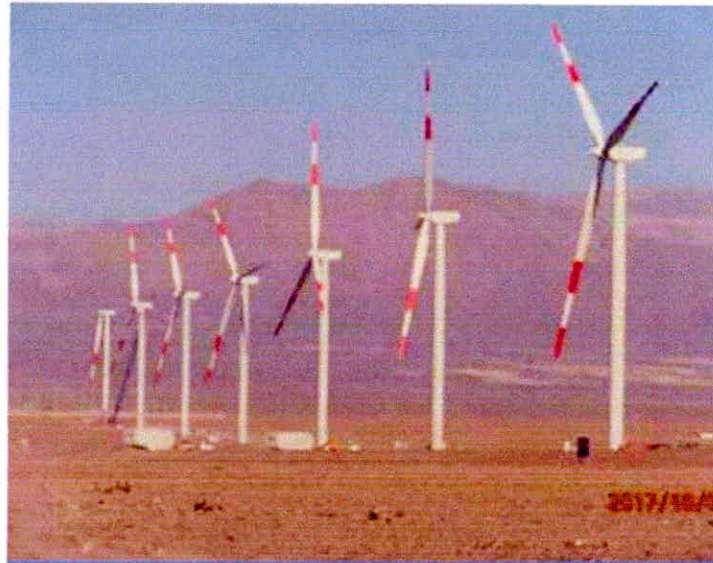
Figura N° 19 Central Eólica Wayra 126 MW
