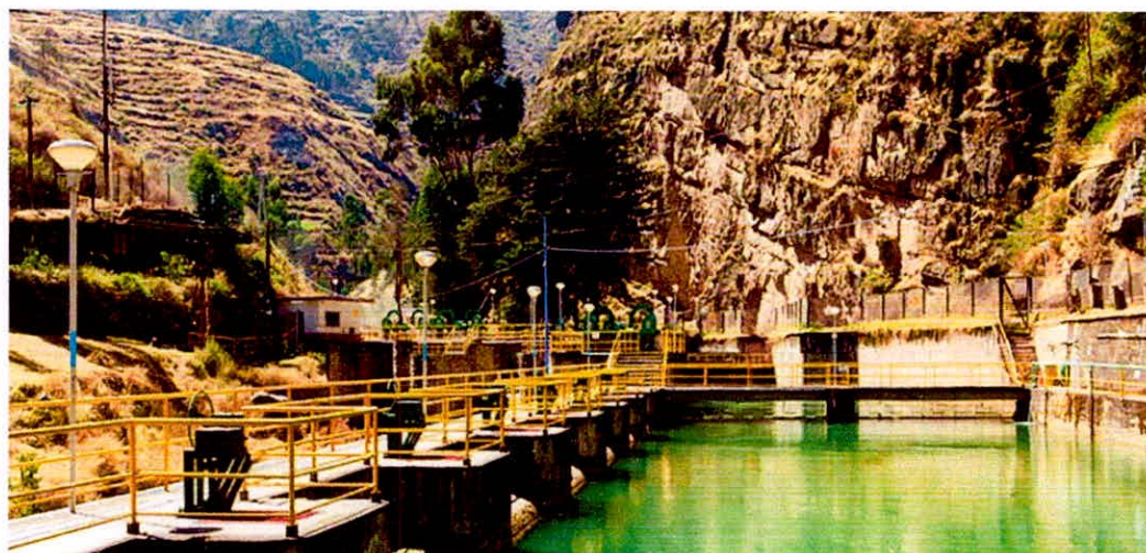
Figura N° 12 Central Hidroeléctrica de HUINCO
