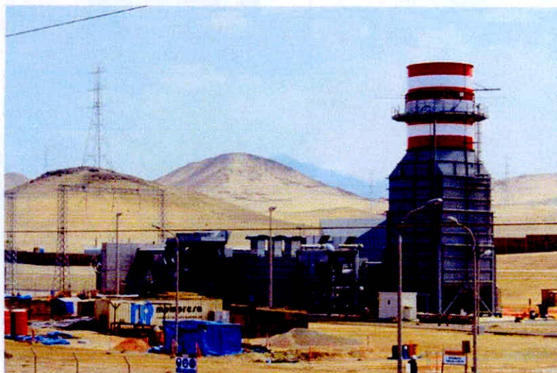
Figura N° 15 Central Termoeléctrica Las Flores
