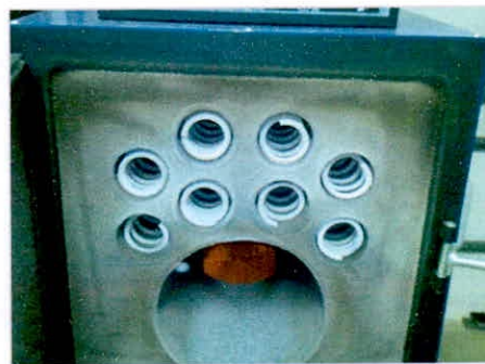
Figura 14. Instalación de turbulador tipo espiral en caldero de biomasa.
