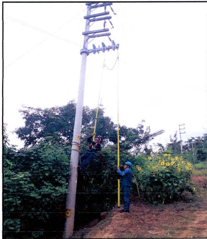
Medición de tensión en MT 22.9KV derivación a Shamboyacu BE-S04
