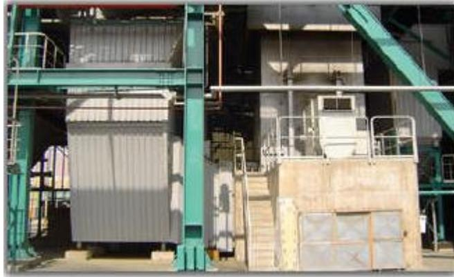
Figura 13. Ventilador de Tiro Forzado
