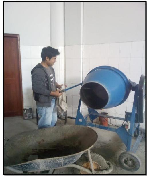
**FOTO N°20:** Se humedeció la mezcladora antes de la preparación del concreto.
