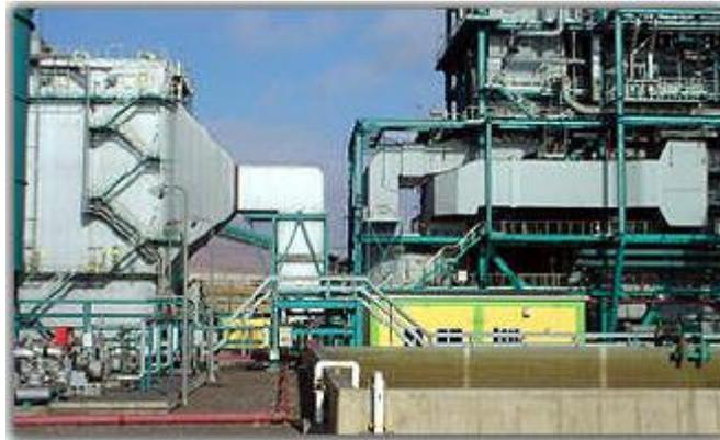
*Figura 18.* Transporte de gases y partículas a través de ductos al precipitador electrostático
