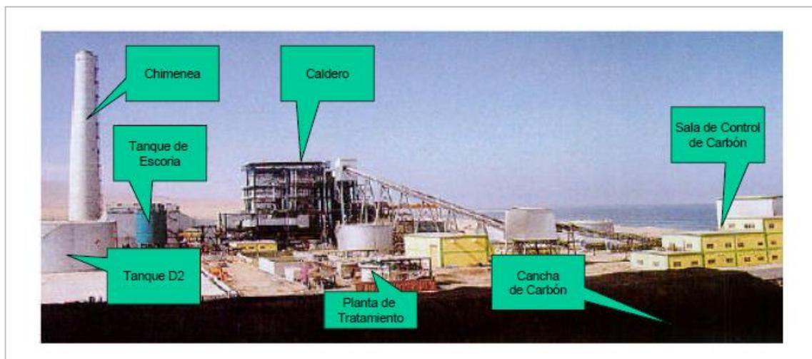
Figura 4. Vista General de la Central Termoeléctrica ILO21
