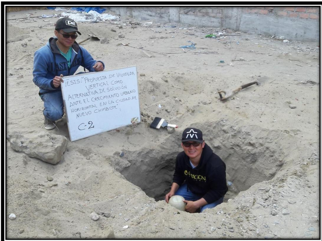
Figura N°01: Ensayo de la densidad de campo por el método del cono de arena en la Calicata - 02.
