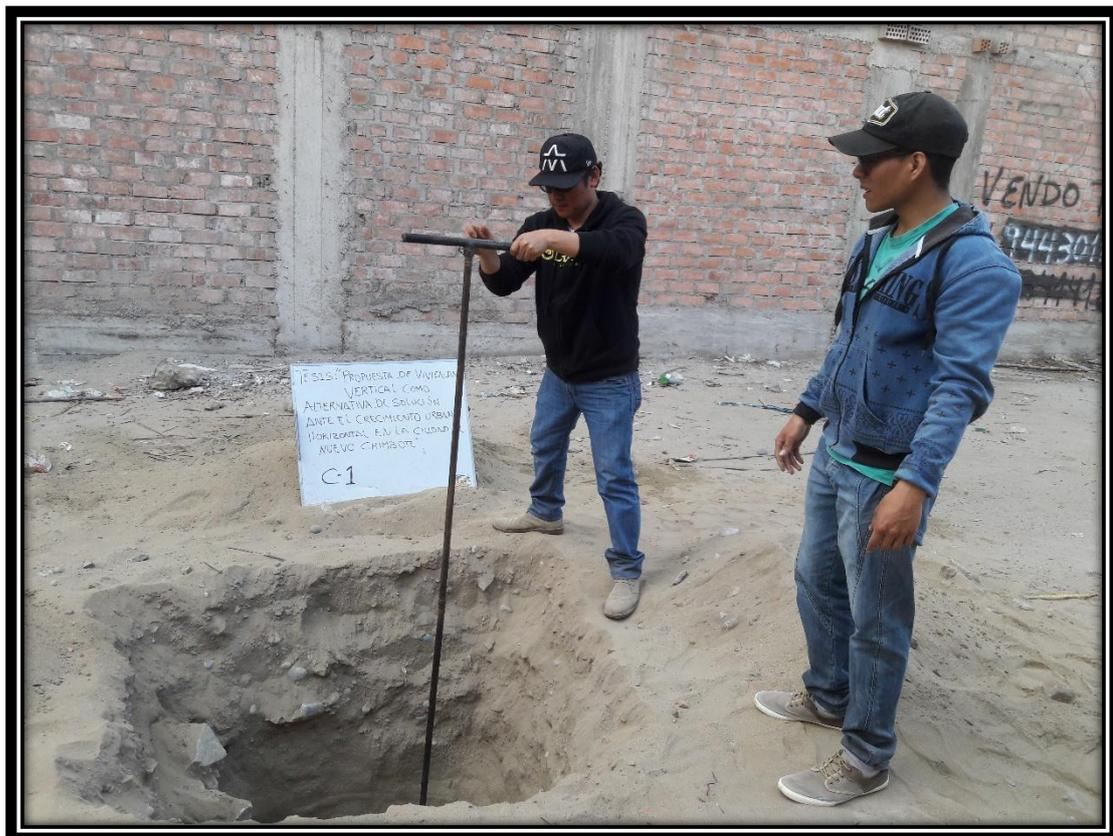
Figura N°01: Trabajo de campo, exploración y muestreo del suelo en la Calicata - 01.
