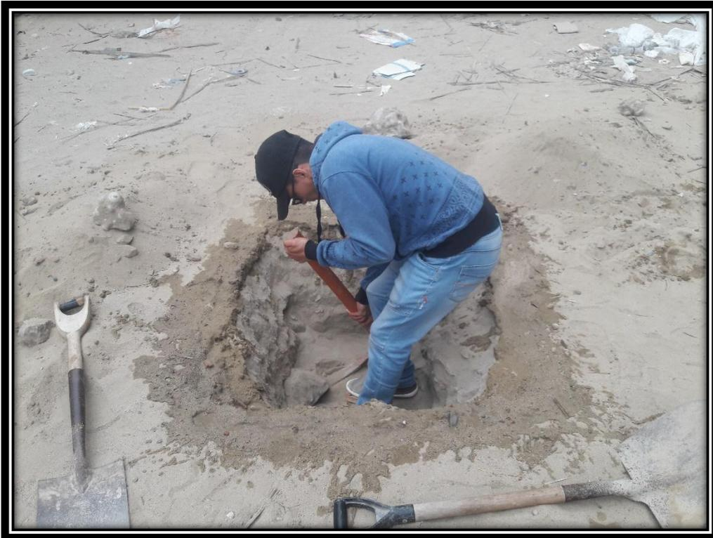
**Figura N°01:** Trabajo de campo, excavación de las calicatas.
