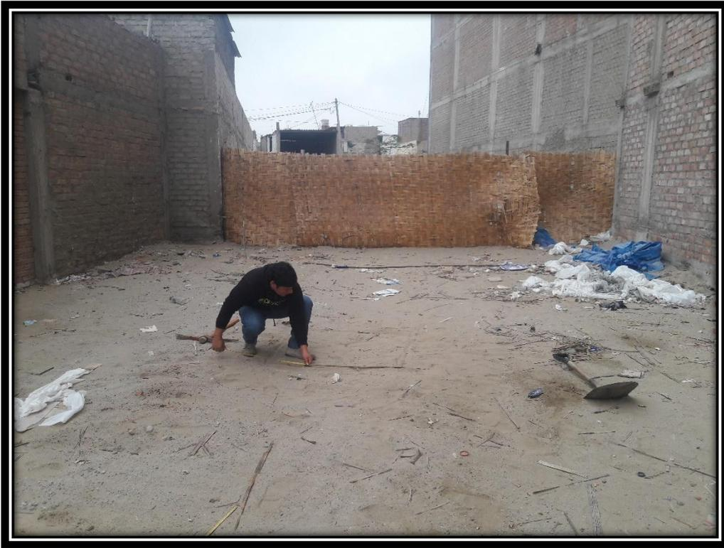
**Figura N°01:** Trabajo de campo, trazo y medición de calicatas.
