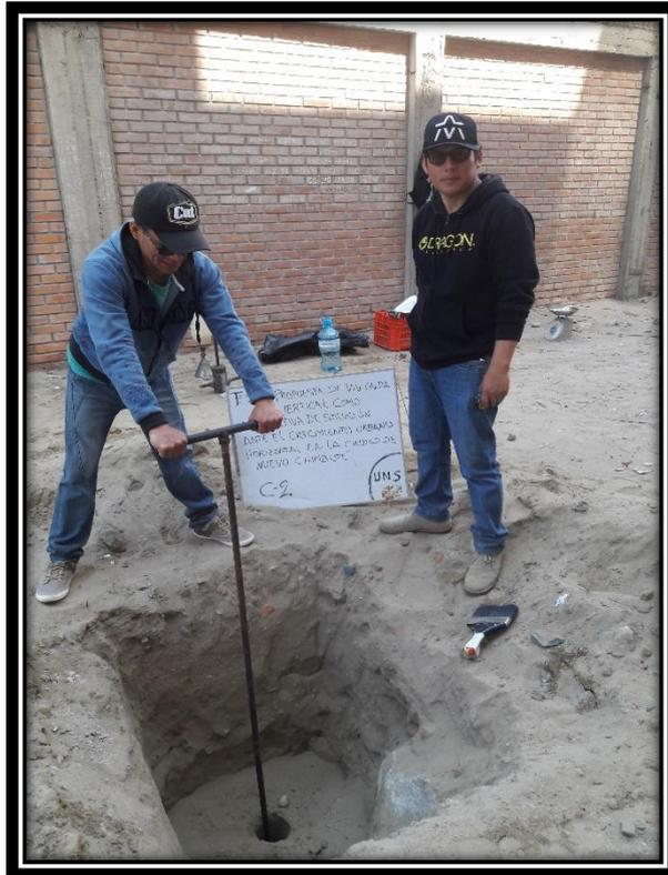
**Figura N°01:** Trabajo de campo, exploración y muestreo del suelo en la Calicata - 02.
