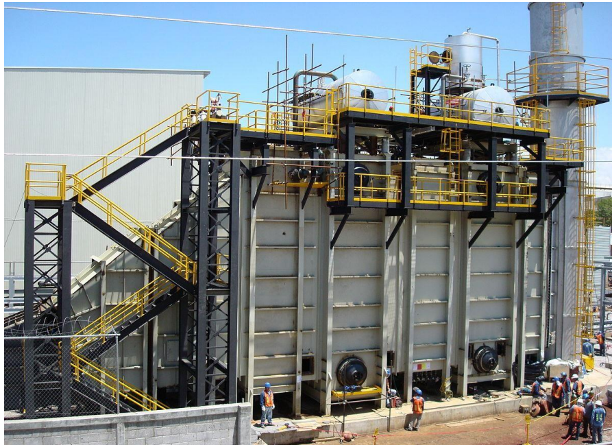
Figura N° 22: Vista lateral de un generador de vapor recuperador de calor
