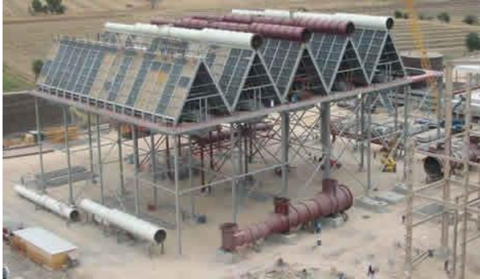
Figura N° 21: Construcción de un aerocondensador de la Empresa KALLPA GENERACION
