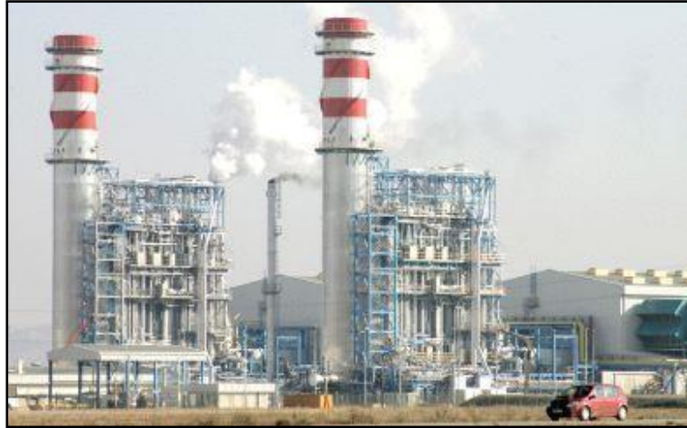
Figura N° 2: Vista de la Central Térmica de Reserva Fría de Ilo
