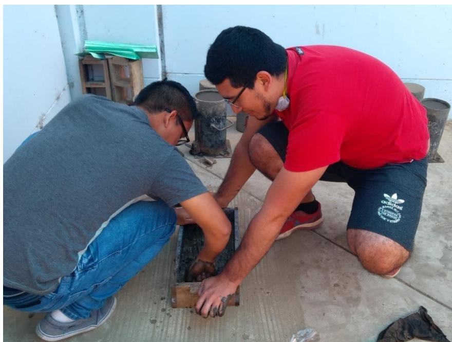
Imagen 20: Moldeo y desmoldeo de los bloques de adobe.
