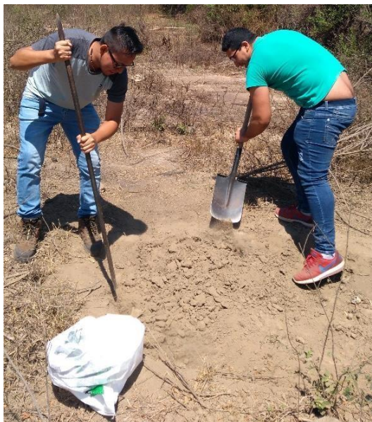
Figura 24: Excavación de calicata en el CC.PP. de Tambar Elaboración Propia
