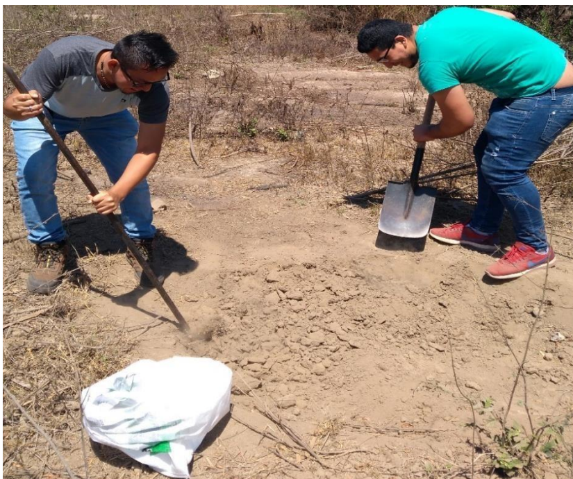
Imagen 01: Excavación de calicata en el centro poblado Tambar.
