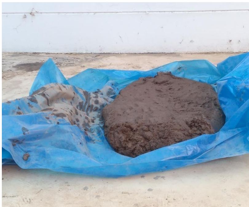
Imagen 13: Etapa de dormir, reposar, o fermentar el barro por dos días.
