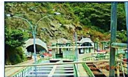
Vista de los Desaradores
