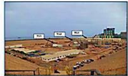
Vista panorámica de la construcción de la Central
