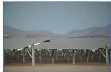
Instalación de Módulos Fotovoltaicos
