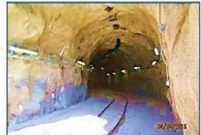
Túnel de acceso a la cámara de carga
