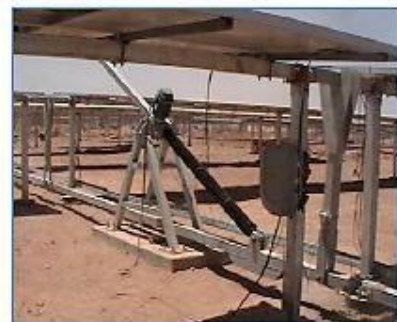
Instalación de Seguidor Solar
