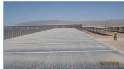
Vista de los módulos instalados
