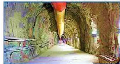
Túnel de Descarga
