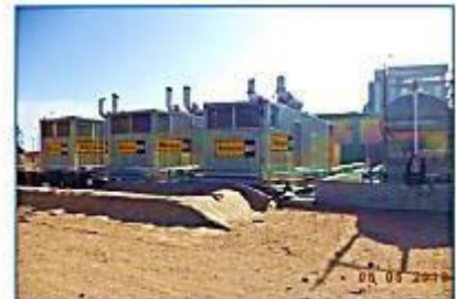
Sistema de Arranque Block Start (3x2,5 MW)
