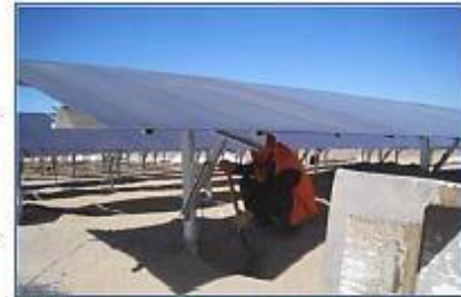
Disposición Final de Módulos Fotovoltaicos
