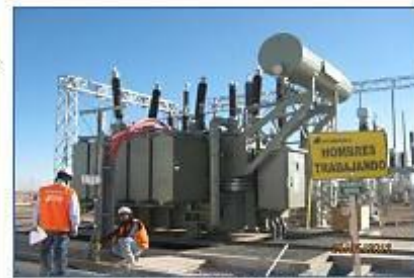
Transformador de Potencia 20 MVA, 23/138 kV (S.E. Central)
