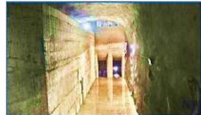
Cámara de Carga
