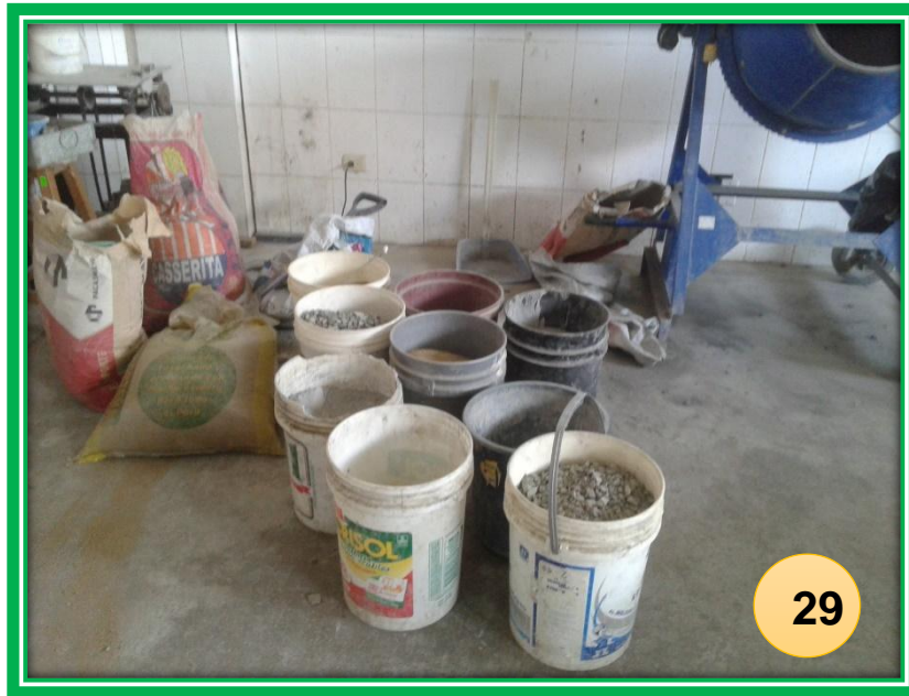
FOTO N°29: elementos para preparar el concreto
