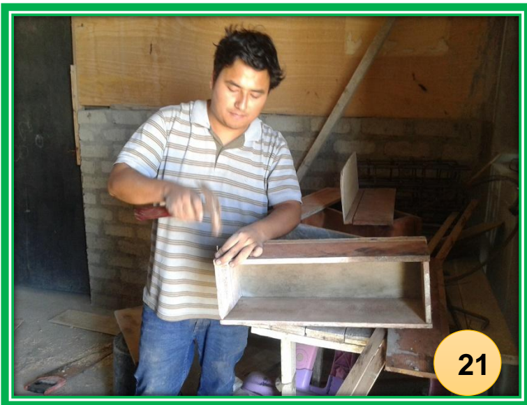
FOTO N°21 y 22: Preparación del encofrado y del acero para las viga
