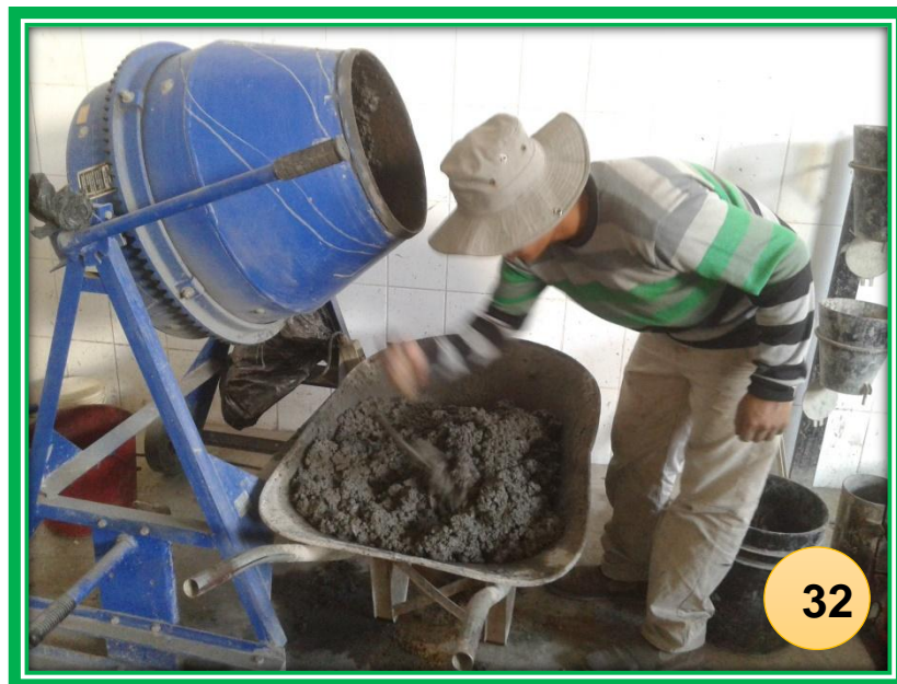
FOTO N°32: Concreto en estado fresco, listo para realizar las probetas y vigas
