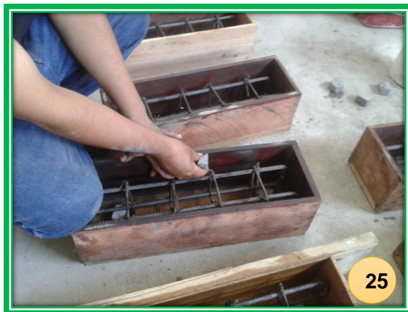
FOTO N°25: Colocación de los dados concreteros en las vigas armadas
