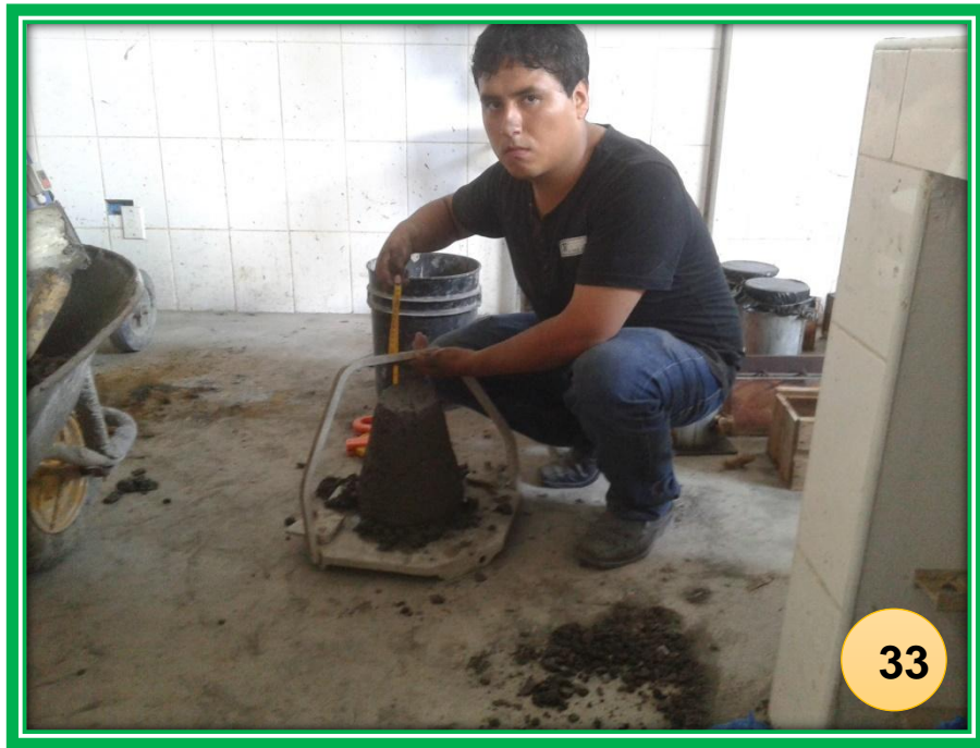
FOTO N°33: Prueba del slump en estado fresco del concreto
