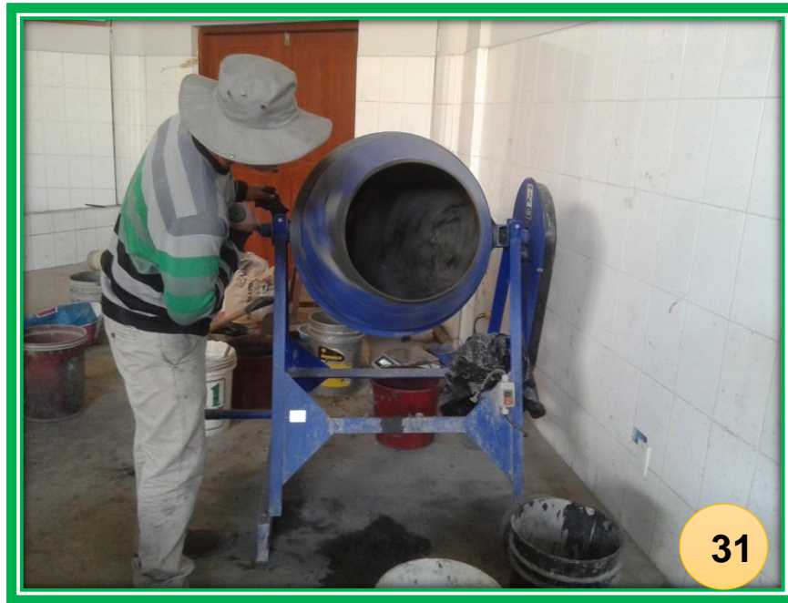
FOTO N°31: Preparación del concreto según las dosificaciones deseadas.
