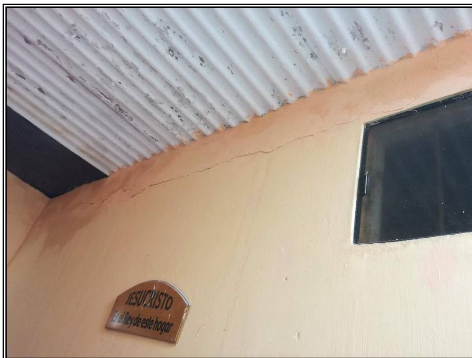
FOTO N° 19: Vulnerabilidad Estructural Alta, mal estado de alero por problemas de exposición al medio ambiente de los aceros. Además, se observan deficiencias en el proceso constructivo.
