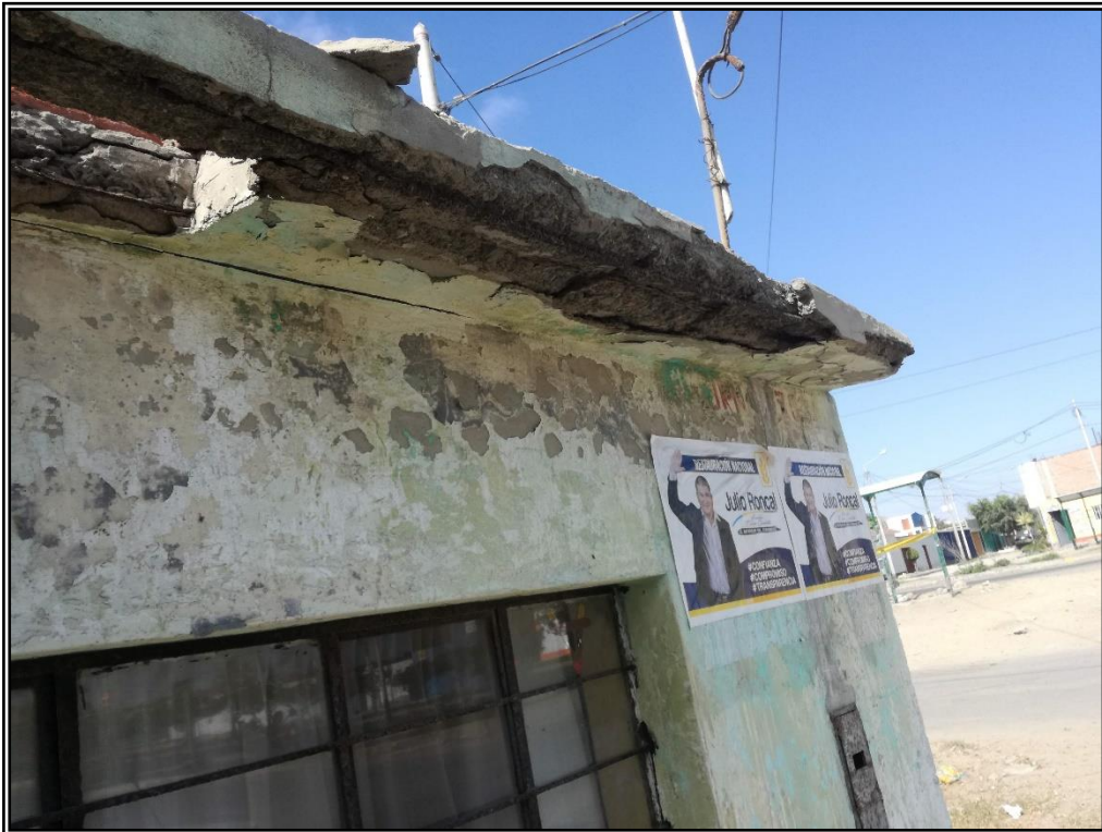
FOTO N° 19: Vulnerabilidad Estructural Alta, mal estado de alero por problemas de exposición al medio ambiente de los aceros. Además, se observan deficiencias en el proceso constructivo.
