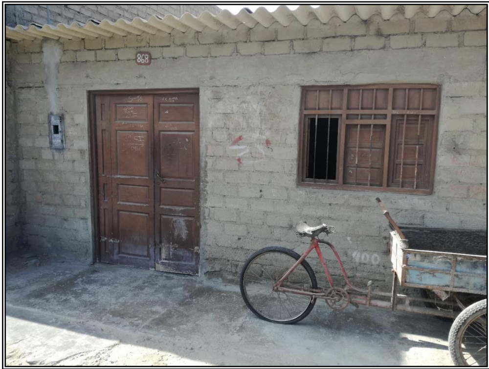
FOTO N° 03: Vivienda no presenta cimentación, muros sin confinamiento vertical. Además de el inadecuado amarre de las cubiertas, vivienda con Diagnóstico de la Vulnerabilidad Estructural Alta.
