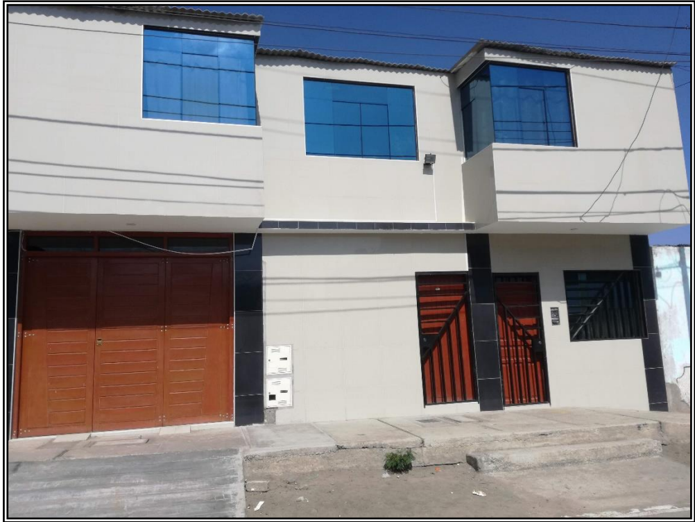
FOTO N° 01: Irregularidad en Planta y en Altura, Vulnerabilidad Estructural Geométrica Media.
