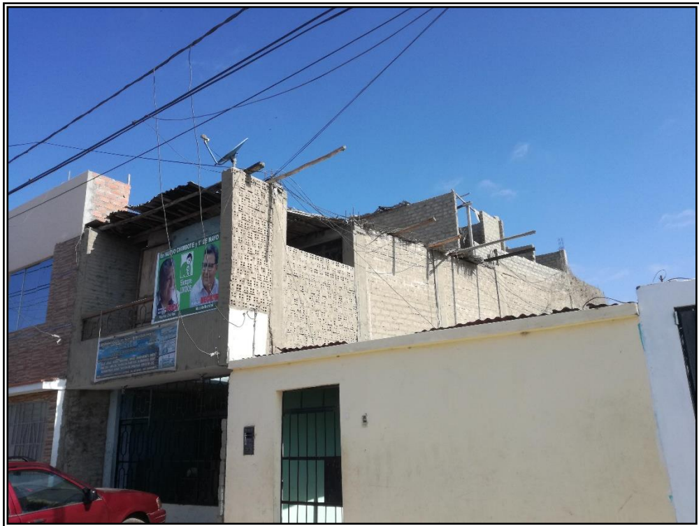
FOTO N° 03: Vivienda no presenta cimentación, muros sin confinamiento vertical. Además de el inadecuado amarre de las cubiertas, vivienda con Diagnóstico de la Vulnerabilidad Estructural Alta.
