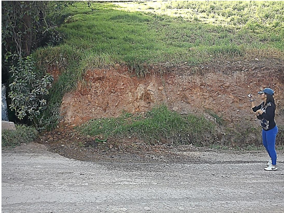
Figura N° 21: Inspección visual preliminar.
