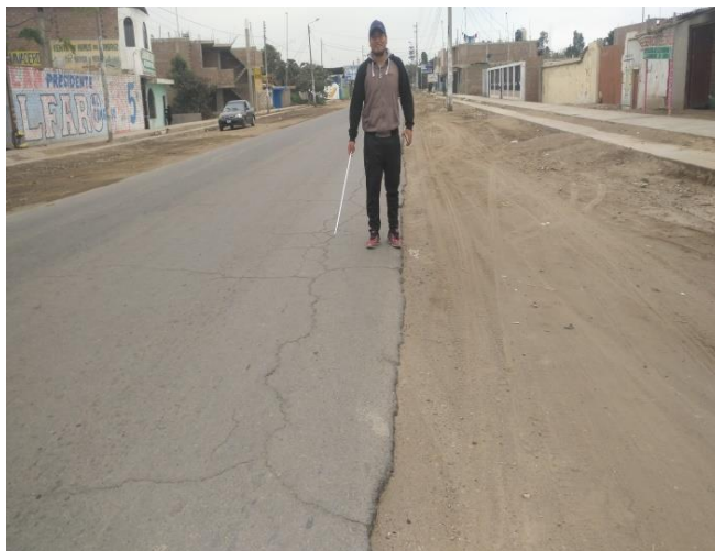
Figura 15: Presencia de agrietamiento de la capa asfáltica – Av. Virú.
