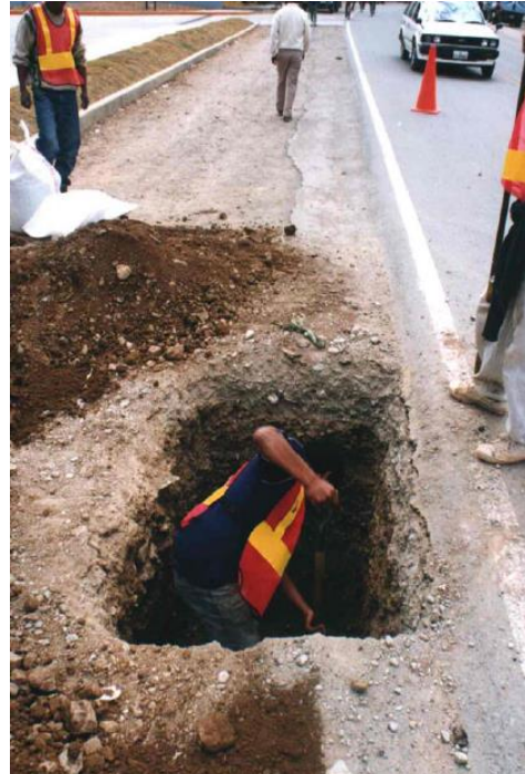
Figura 40: Excavación de Calicata determinación de espesores Carretera Virú.
