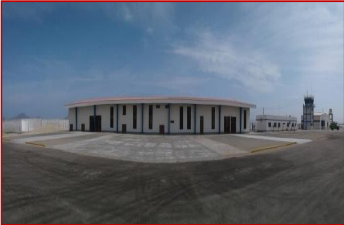
FOTO N° 03: Vista de los hangares Aeropuerto de Chimbote, lugar donde se aloja y da mantenimiento a ciertas aeronaves.
