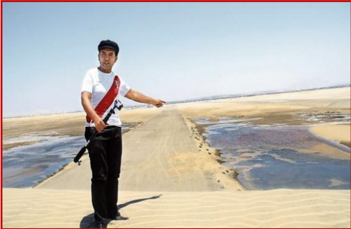
FOTO N° 05: El alcalde de Nuevo Chimbote, Valentín Fernández, dando a conocer las filtraciones de aguas subterráneas, las cuales, en primera hipótesis, eran el principal daño que recibía la pista de aterrizaje del Aeropuerto de Chimbote.
