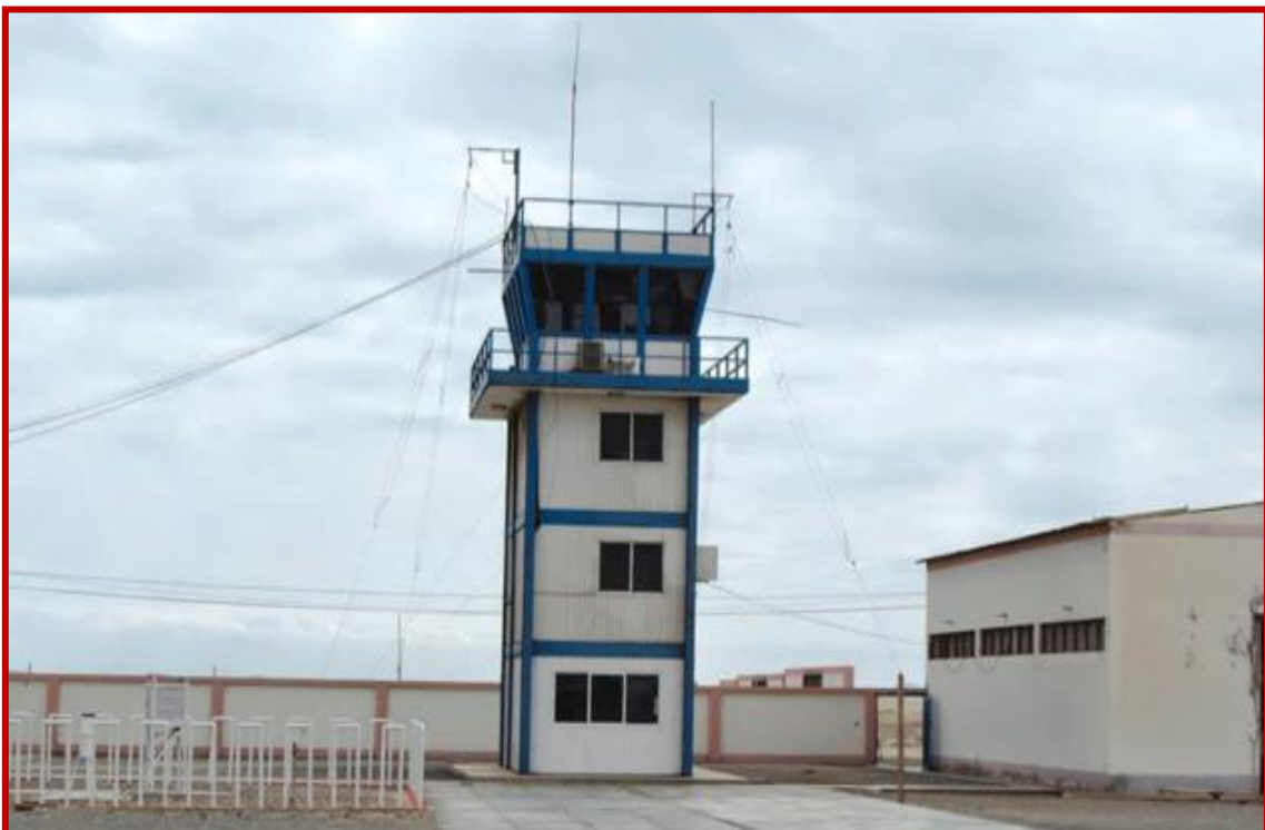
FOTO N° 02: Torre de Control del Aeropuerto de Chimbote, lugar donde se registran los vuelos diarios de ingreso y salida de aeronaves.
