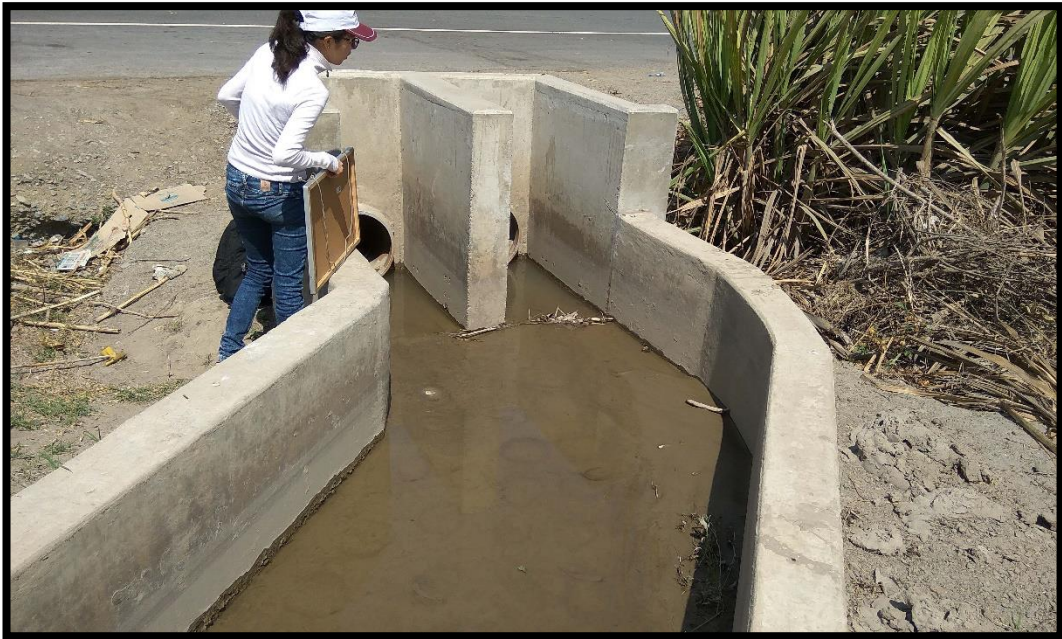
FOTO N°09: Evaluación visual del drenaje transversal.
