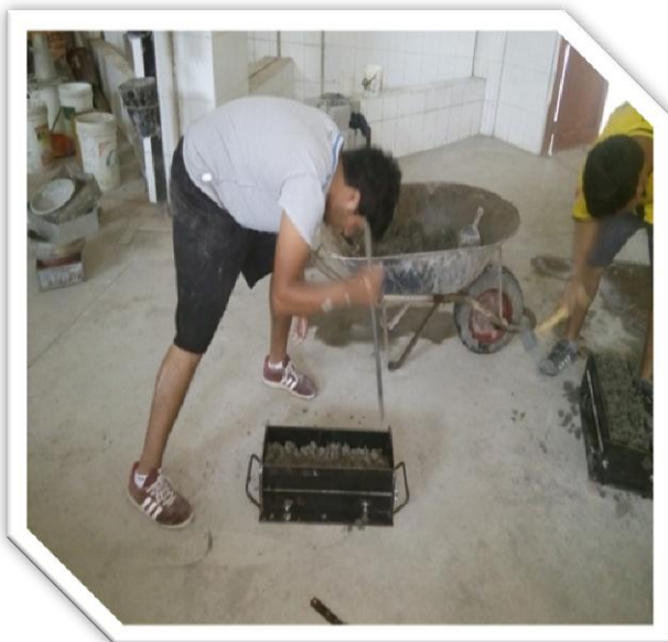
Foto 23: Chuseo de vigas con golpes de 54 por 3 capas, (con golpes de martillo de goma por cada capa).
