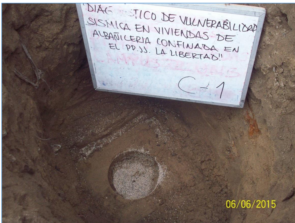
FOTOGRAFIA N° 02.- Densidad de Campo en la Calicata N° 01.
