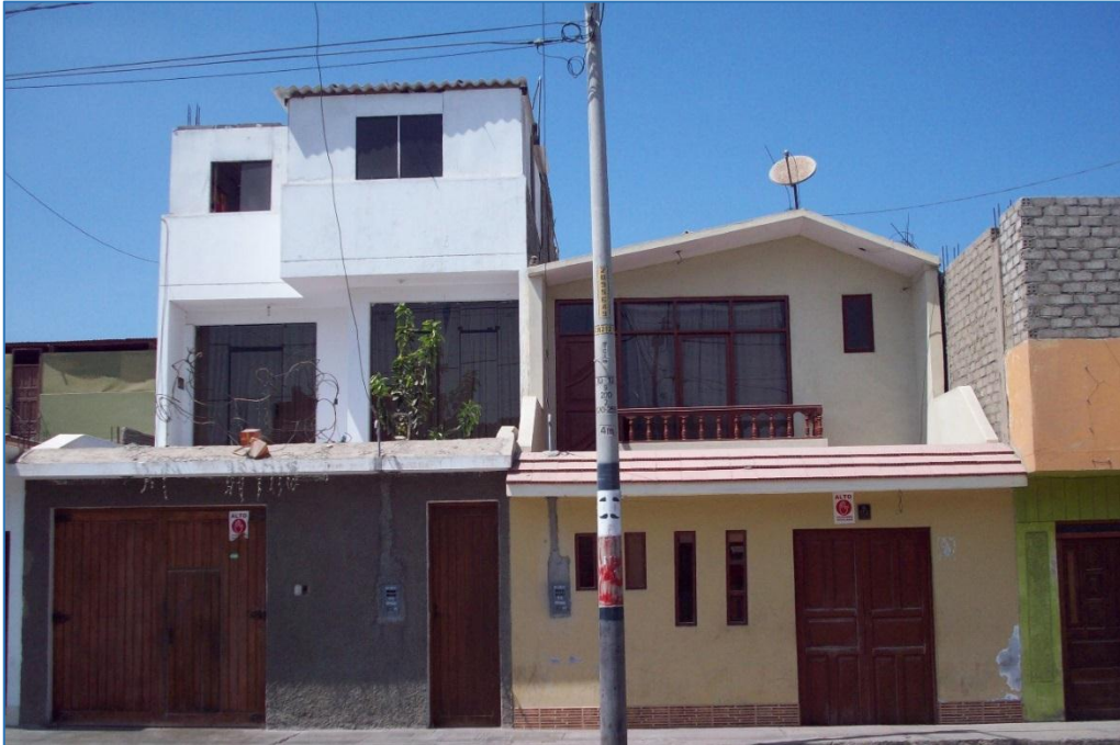
FOTOGRAFIA N° 18.- Irregularidad en Elevación y en planta en viviendas ubicadas en la Mz. 13 del PPJJ La Libertad.
