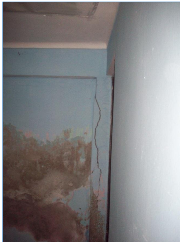
FOTOGRAFIA N° 04.- Grietas profundas en columnas en Mz.03 Lot. 16 del PPJJ La Libertad.
