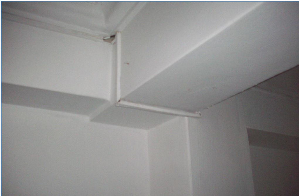
FOTOGRAFIA N° 02.- Conexión viga –columna en Mz.02 Lot. 28 del PPJJ La Libertad.
