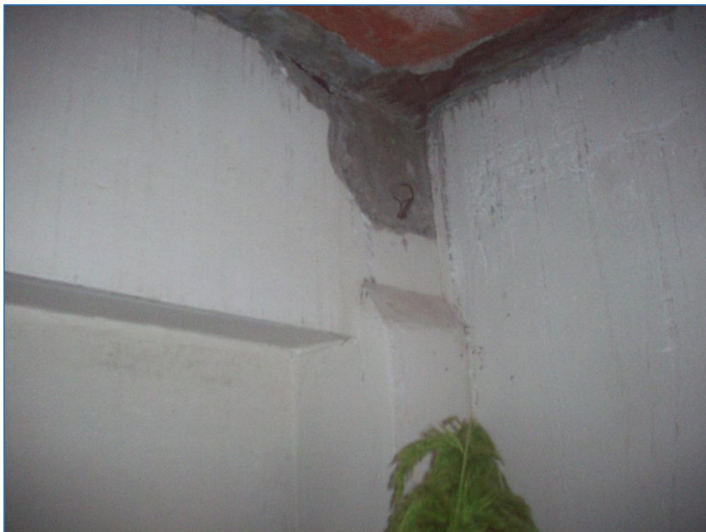
FOTOGRAFIA N°15.- Conexión viga –columna en Mz.19 Lot. 11 del PPJJ La Libertad.
