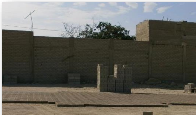
Figura N°12. Almacenamiento de los ladrillos
