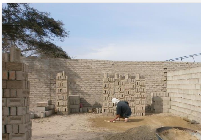
Figura N°9. Preparación del terreno para el tendido.
