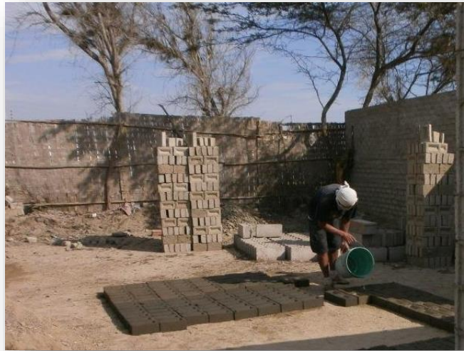
Figura N°11. Curado del ladrillo.
