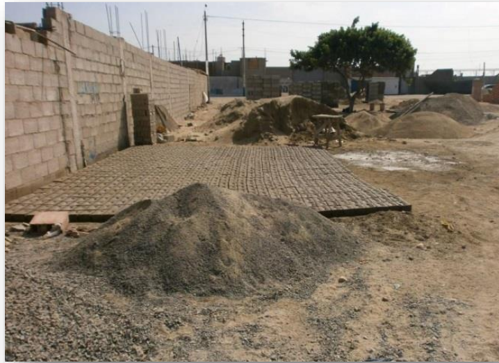
Figura N°10. Tendido del ladrillo.
