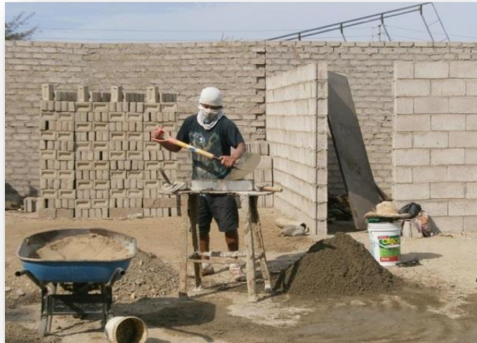
Figura N°8. Moldeado de ladrillo.
