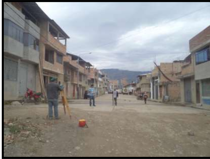
Foto N°05 realizando el levantamiento topográfico del Jr. Francisco Cadenillas.
