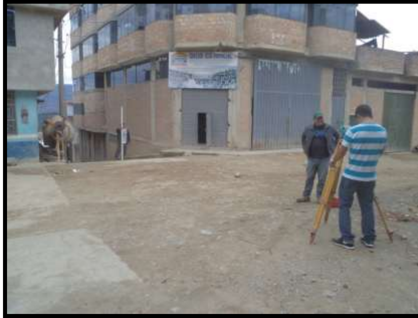
Foto N°01 instalando la primera estación para el levantamiento topográfico.
