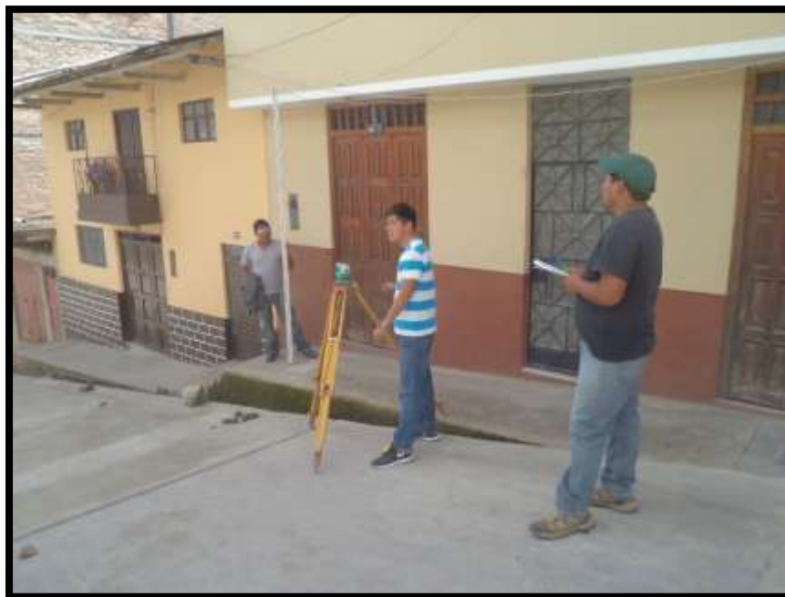
Foto N°06 levantamiento topográfico de las conexiones domiciliarias existentes
