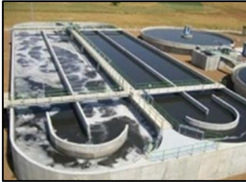
Figura N° 19: Cámara de mezclado con agentes purificadores
