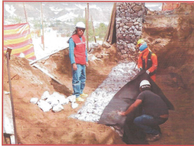
Figura 07: Muro con Terramesh System (Suelo Reforzado). Fuente: Elaboración de los Tesistas.
