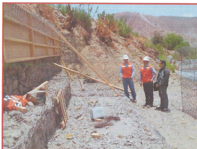
Figura 08: Muro con Gaviones. Fuente: Elaboración de los Tesistas.
