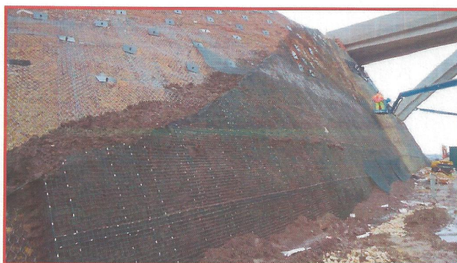
Figura 06: Muros Anclados. Fuente: Elaboración de los Tesistas
