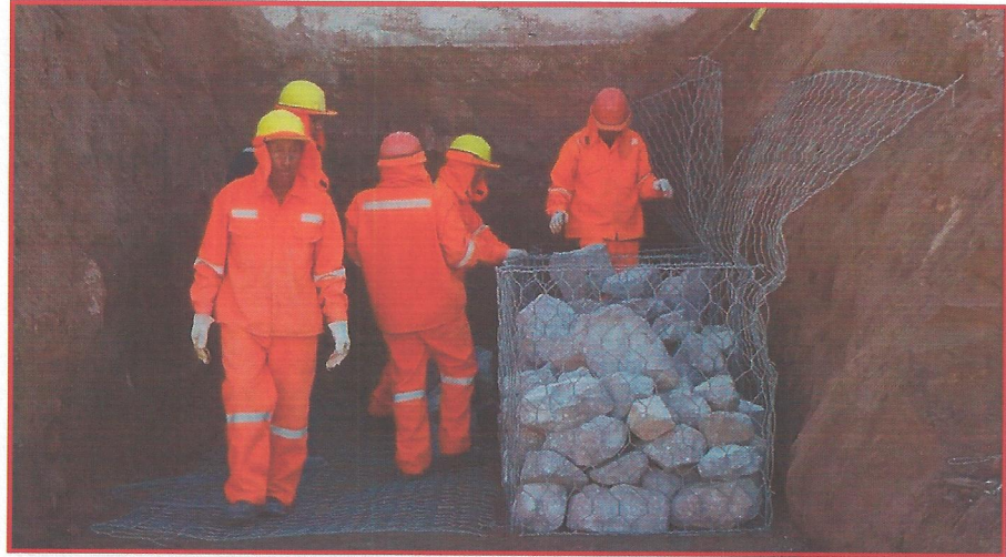
Figura 29: Llenado de Piedra del Terramesh System. Fuente: Elaboración de los Tesistas.
