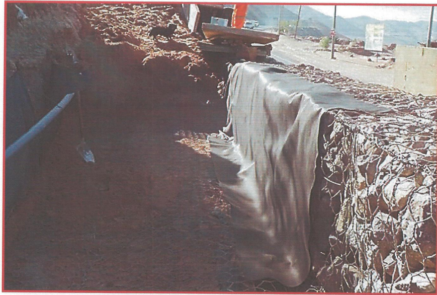
Figura 27: Colocación del Geotextil no Tejido
