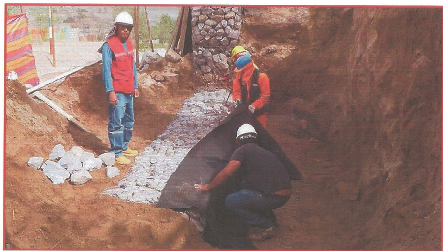
Figura 30: Colocación del Geotextil no tejido. Fuente: Elaboración de los Tesistas.
