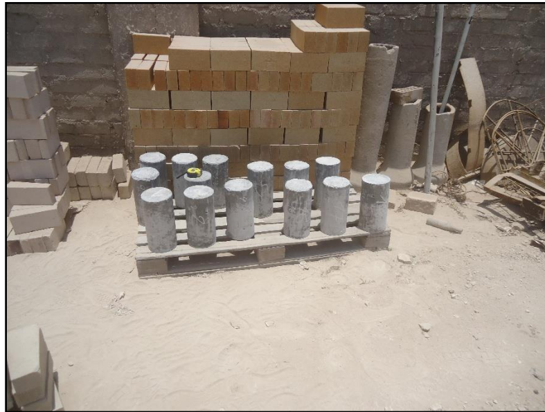
FOTO N° 11: SE APRECIA EL ALINEAMIENTO DE LAS PROBETAS, CON SU RESPECTIVA ENUMERACION PARA LA COLOCACION EN EL HORNO.
