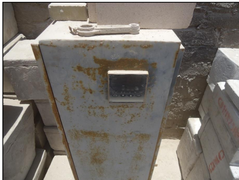
FOTO N° 12: EQUIPO DE CONTROL DE TEMPERATURA DE CALOR.
