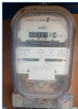
**Figura N° 2. 2. Medidor Electromecánico indirecto Landis Inepar.**
