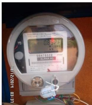
**Figura N° 2. 3. Medidor Electrónico marca Elster A3RL**
