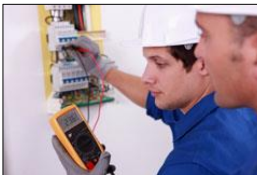
Figura 04. Diagnóstico de la calidad de la energía eléctrica Fuente. Procobre-Chile.
