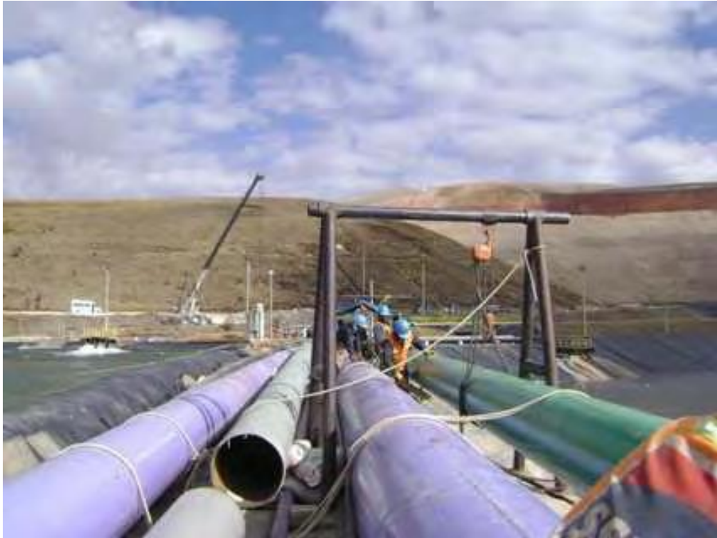
Figura 2. Trabajos de instalación de tuberías
