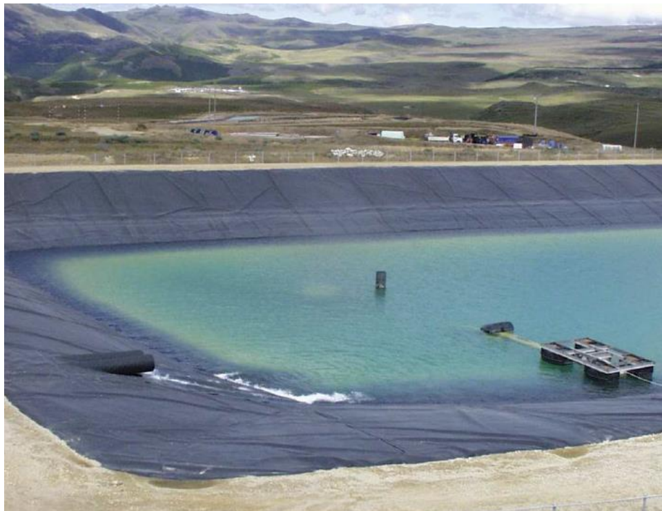
Figura 3. Poza de Retención de Aguas Ácidas
