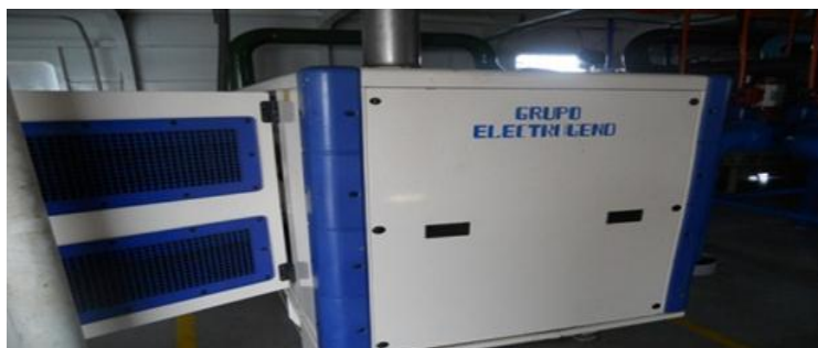
Figura 2.15: Grupo electrógeno FG-Wilson
