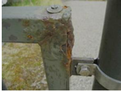
Figura 3.6 : Representación de la corrosión Galvánica.
