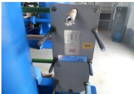
Figura 2.11: Intercambiador de calor de Placas de Separador de aceite
