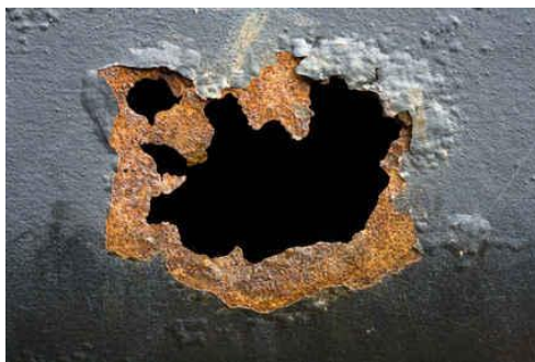
Figura 3.3 : Representación de la corrosión por picadura
