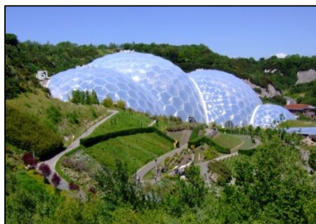
Figura 2.14: Invernaderos geotérmicos Fuente: Meteorología en red
