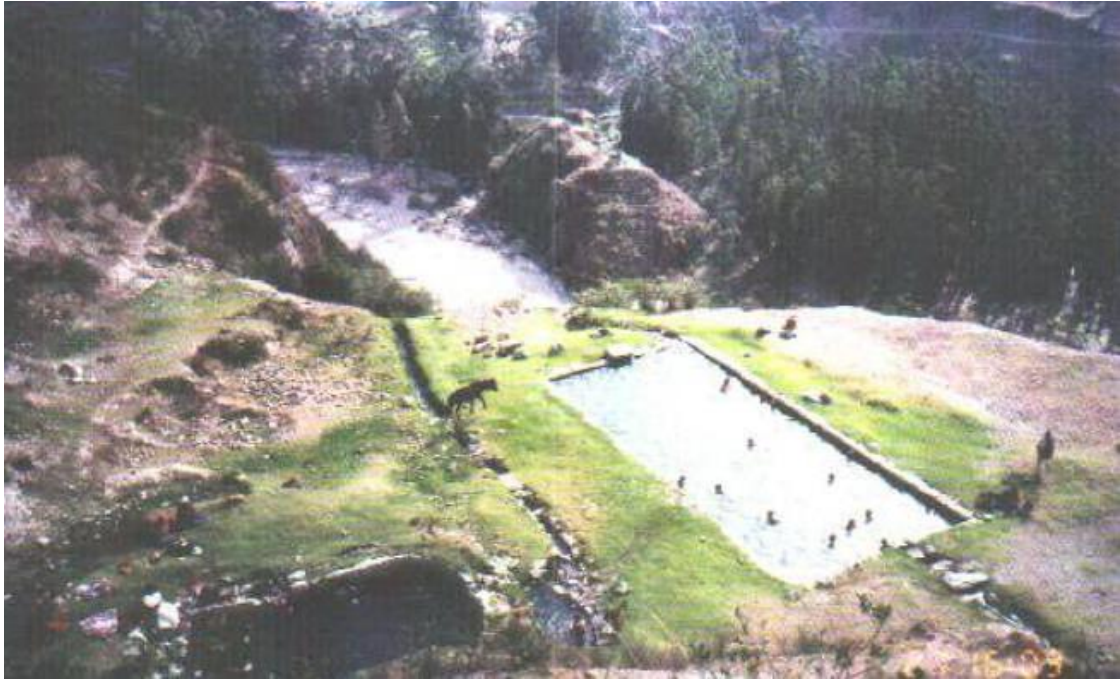
Fuente Cochaconchucos (dos piscinas de concreto a la margen derecha del rio)
