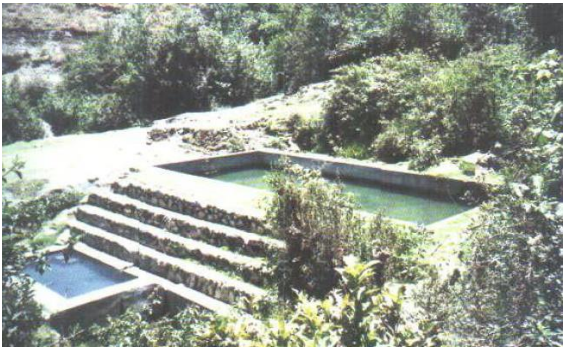
Fuente Huandoval (dos piscinas de concreto)
