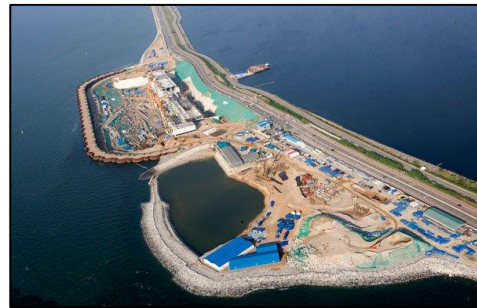
Figura 2.2: Central Mareomotriz Sihwa Lake (Gyeonggide - Corea del Sur) de 254 MW / 10 turbinas de bulbo sumergidas Fuente: Fieras de la Ingeniería
