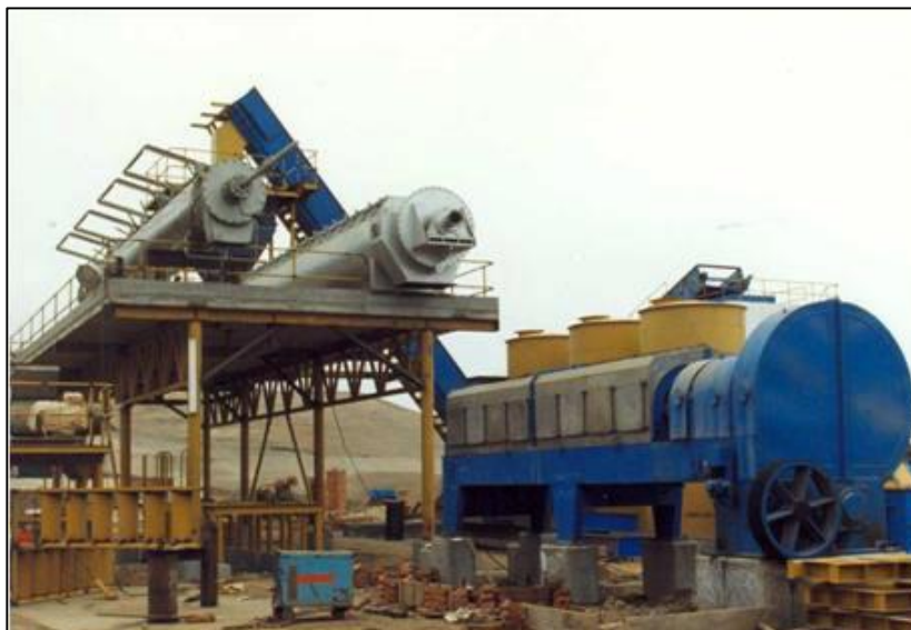
Figura 03. Montaje de cocinadores para proceso. Fuente: Instituto tecnológico Pesquero.
