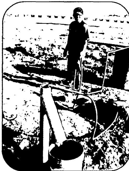
FOTO N°57: Observamos cómo se va extrayendo la arena que se encuentra dentro del micropozo
