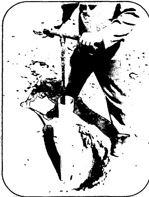
FOTO N°43: Continuando con la excavación del micropozo.
