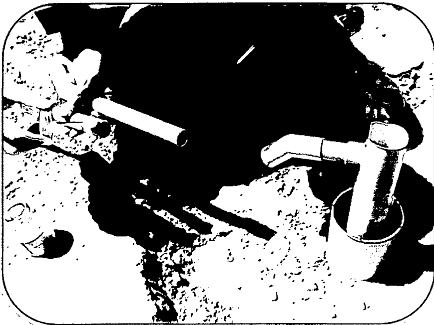
FOTO N°65: Se empieza a armar la línea de tubería de succión
