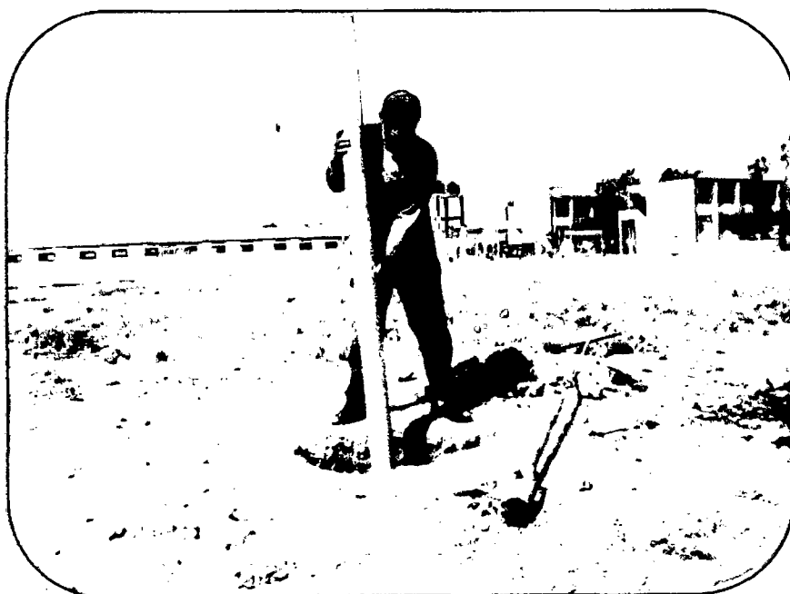
FOTO N°41: Colocación de la tubería de 4", dentro del micropozo barrenado, usado como protección para seguir excavando
