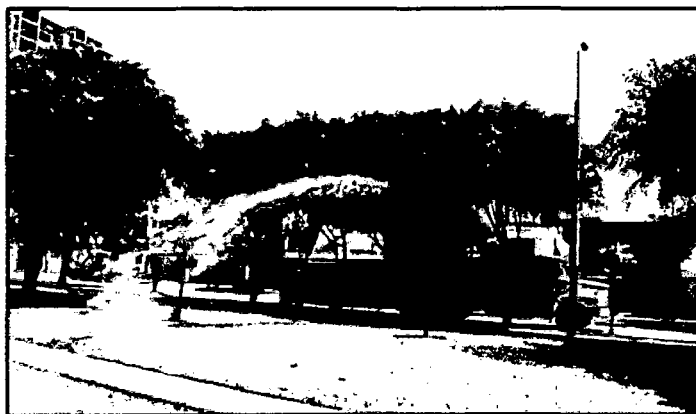
Foto N°01: Riego por medio de camiones cisternas.
