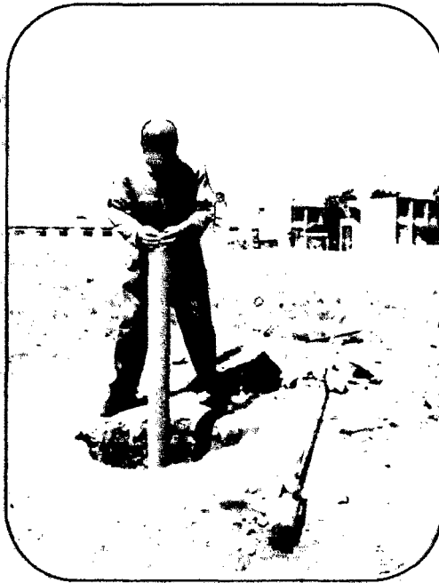
FOTO N°42: hundimiento manual del tubo de protección de pvc.
