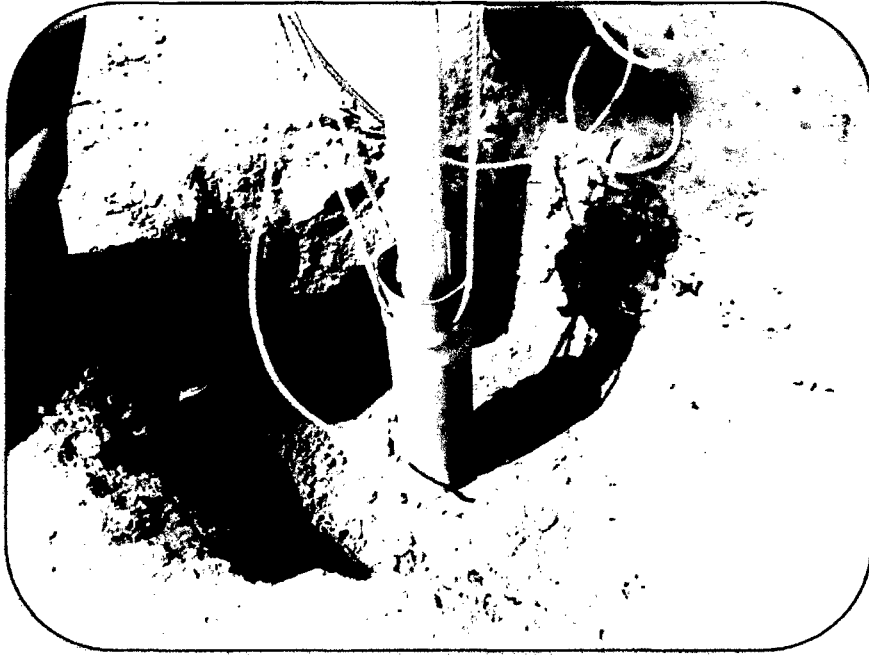
FOTO N°58: Procedemos a elevar los tubos de 4" de protección, para que el filtro plástico, esté en contacto con la piedra filtro y el agua subterránea.
