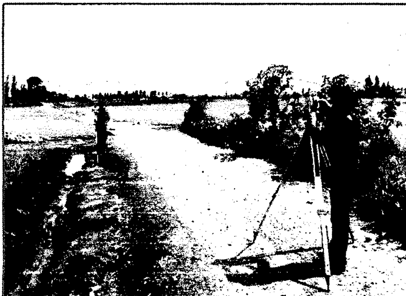
FOTO N°03: Levantamiento topográfico de la trocha que une el Anexo San Juanito con la Villa Guadalupe.
