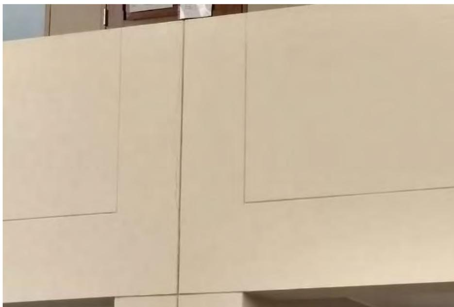
**FOTO N° 06.** En la imagen se muestra una fisura en la unión entre el pórtico de entrada de la I.E.I. y el bloque de edificios administrativos.
