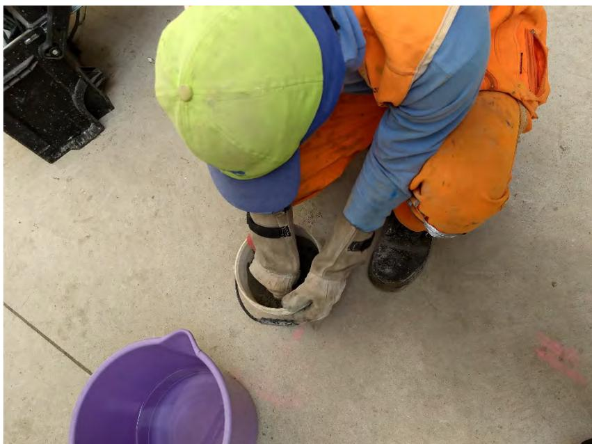
**FOTO N° 18.** En la imagen se observa la preparación del concreto autocompactante (Mortero reforzado con fibras SIKA REP), para reposición de los agujeros producto de la extracción de diamantinas.
