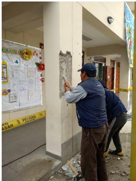
**FOTO N° 12.** En la imagen se puede observar al personal de apoyo realizando el picado del recubrimiento de la columna, a fin de poder realizar el ensayo de esclerómetro en el Elemento C-6 – D (Muestra M2) con normalidad.
