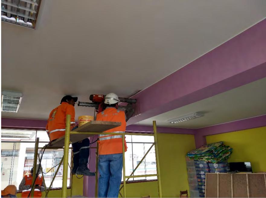
**FOTO N° 23.** En la imagen se muestra la extracción de la muestra M3.
