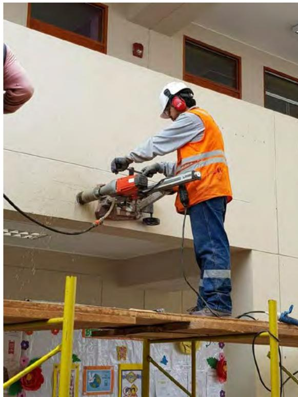
**FOTO N° 16.** En la fotografía se observa el proceso de perforación para la extracción de la Muestra M1.
