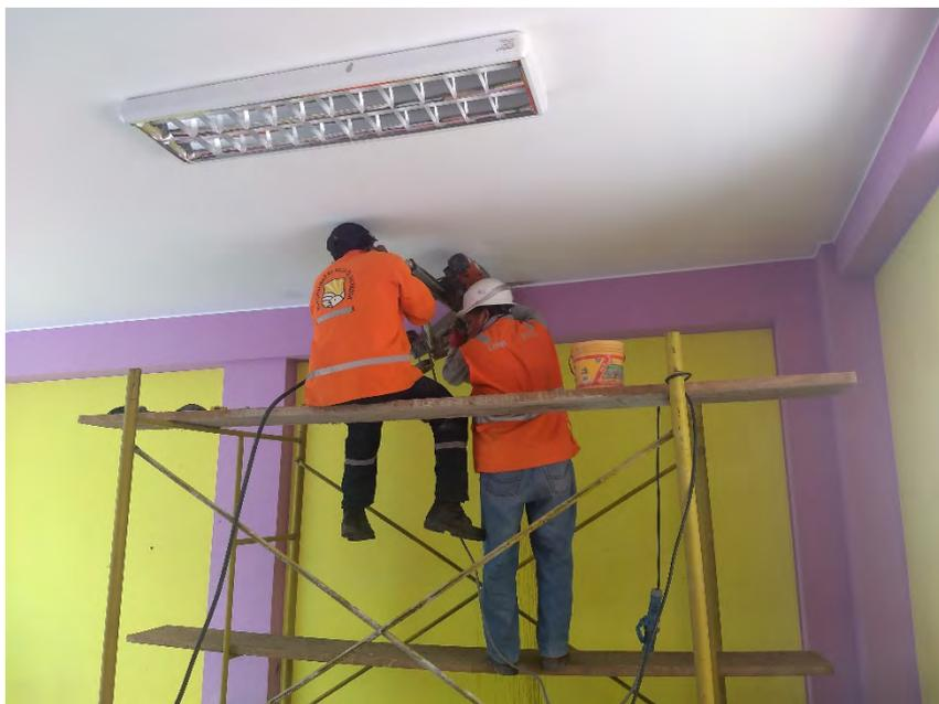
**FOTO N° 27.** En la imagen se muestra el proceso de extracción del prisma diamantino, muestra M6.
