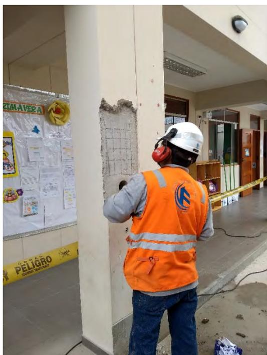
**FOTO N° 14.** En la imagen se puede observar el marcado de la superficie de la columna propio del ensayo de esclerometría - elemento C-6 – D (Muestra M2).
