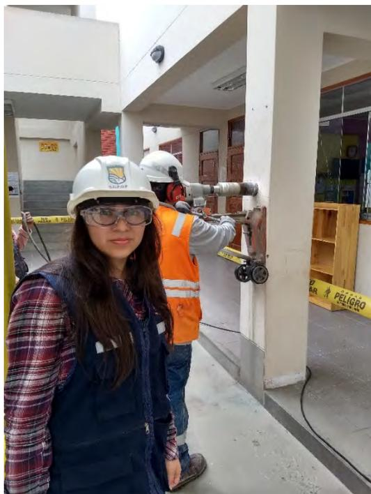
**FOTO N° 13.** En la imagen se puede observar al personal encargado de la extracción de primas diamantinos, realizar el proceso de perforación correspondiente. Esto en el Elemento C-6 – D (Muestra M2).
