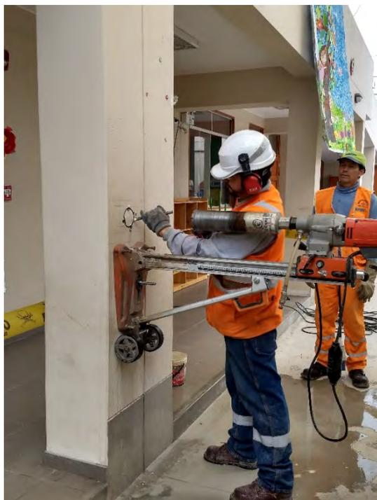
**FOTO N° 09.** En la imagen se visualiza al personal encargado de los trabajos retirando de manera cuidadosa la muestra M3 correspondiente al elemento C-6 – I.
