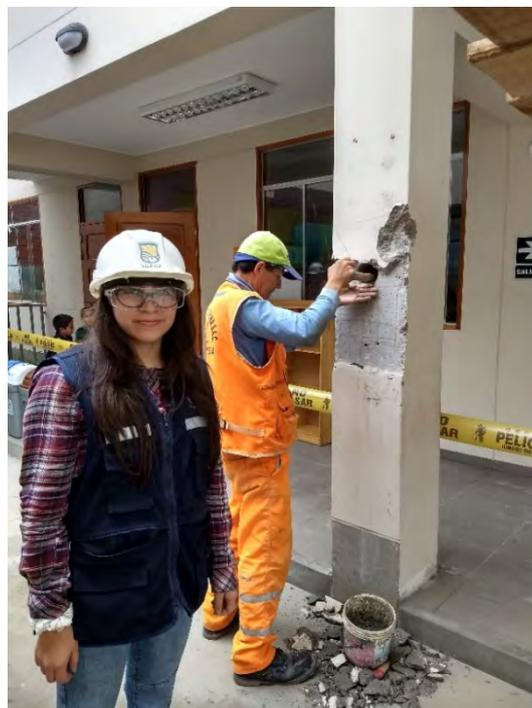
**FOTO N° 20.** En la imagen se observa el proceso de sellado del Punto de donde se extrajo la Muestra M2 con el Mortero reforzado con Fibras SIKAREP.
