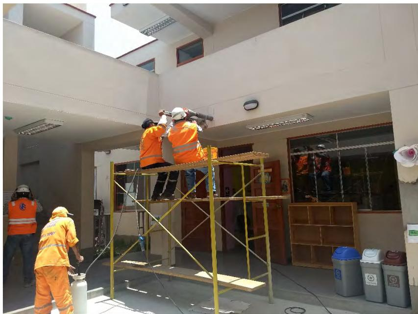
**FOTO N° 32.** En la imagen se muestra el proceso de extracción del prisma diamantino M11.
