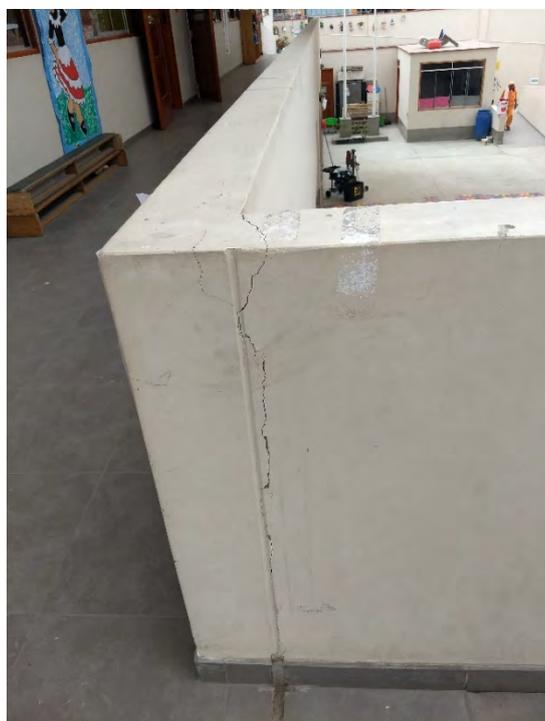
**FOTO N° 04.** En la imagen se observa una fisura vertical, formada en la unión del parapeto perteneciente al bloque de aulas, y el parapeto propio del volado de la escalera independiente colindante.
