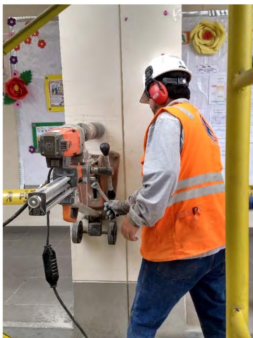
**FOTO N° 08.** En la imagen se visualiza el proceso de perforación para la extracción de la muestra M3 correspondiente al elemento C-6 – I.
