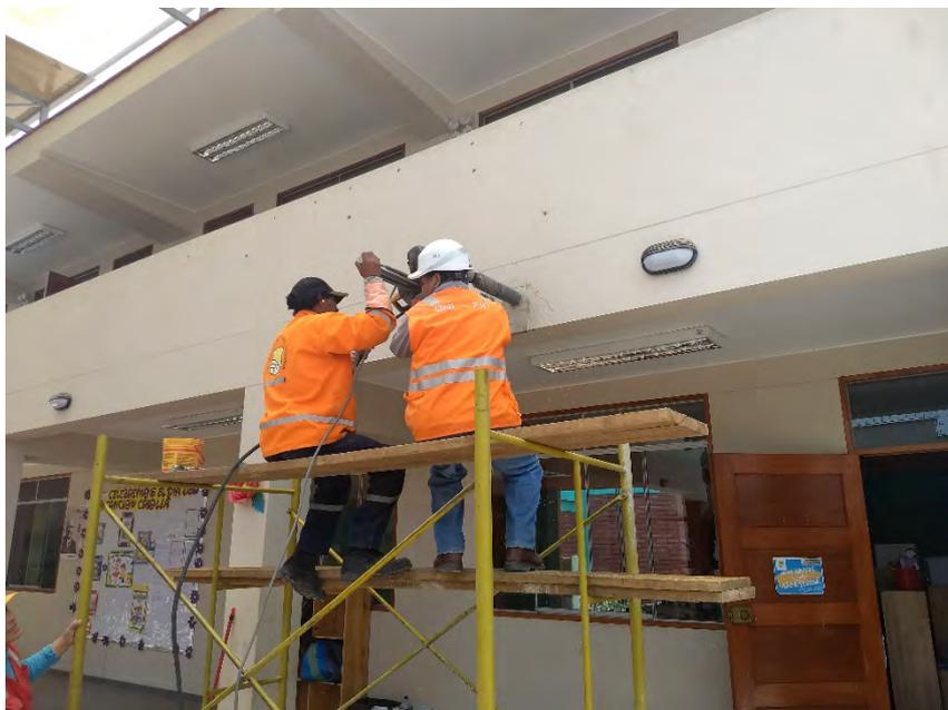
**FOTO N° 28.** En la fotografía se muestra el proceso de extracción de la muestra M12.
