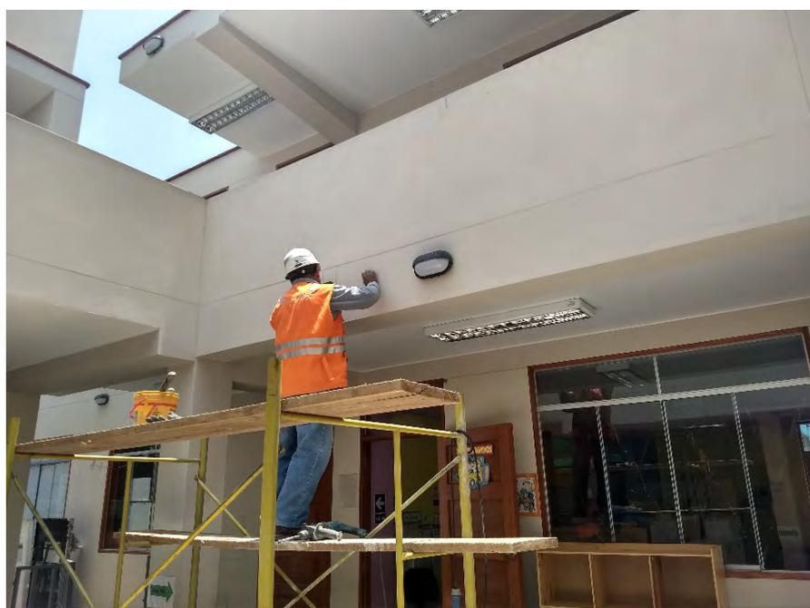
**FOTO N° 31.** En la imagen se muestra la identificación de acero de refuerzo para la extracción de la muestra M11.
