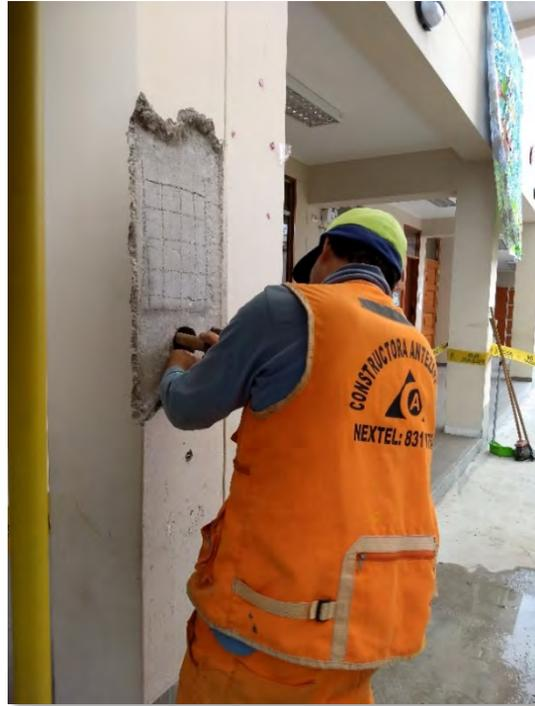
**FOTO N° 19.** En la imagen se observa el proceso de sellado del Punto de donde se extrajo la Muestra M3 con el Mortero reforzado con Fibras SIKAREP.
