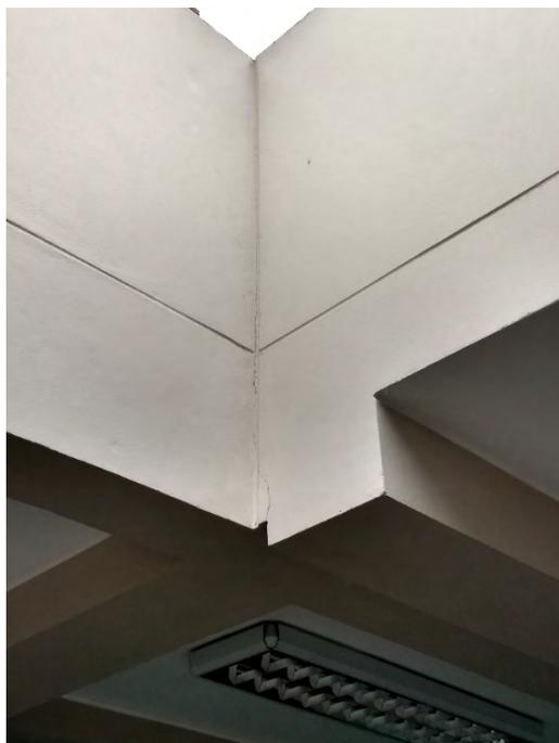
**FOTO N° 05.** En la imagen se muestra una fisura en la unión entre el final del bloque de aulas de la I.E.I. Santa Rosa de Lima y el bloque correspondiente a la escalera independiente de acceso al segundo nivel.
