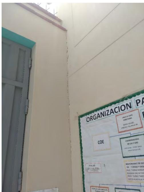
**FOTO N° 02.** En la imagen se muestra una fisura en la unión entre el pórtico de entrada de la I.E.I. y el bloque de edificios administrativos.
