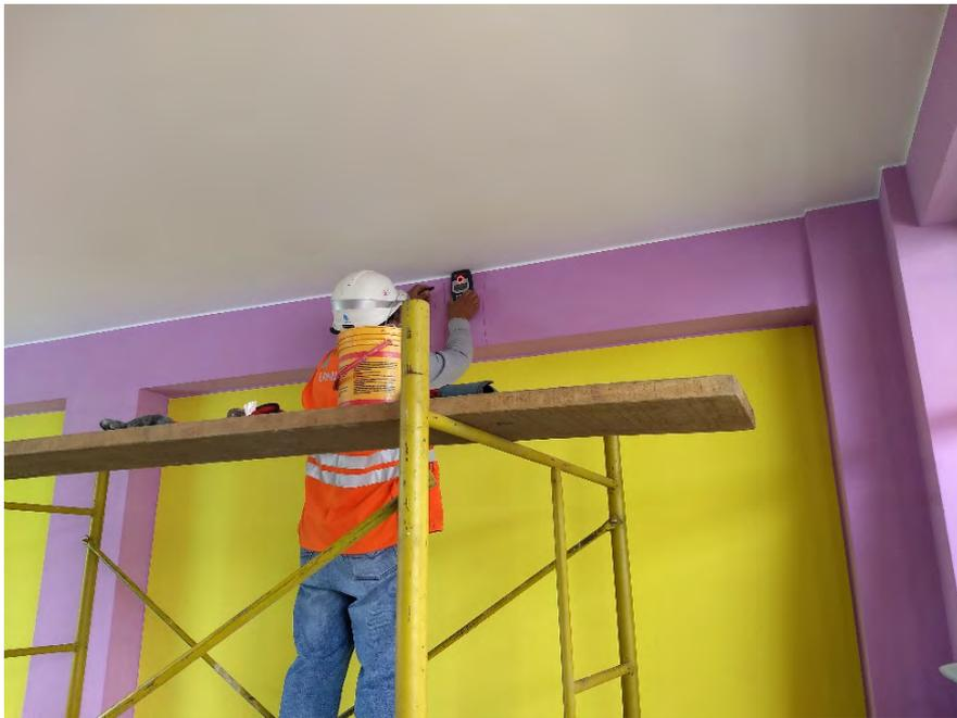
**FOTO N° 24.** En la imagen se muestra la identificación de acero de refuerzo para la extracción de la muestra M4.
