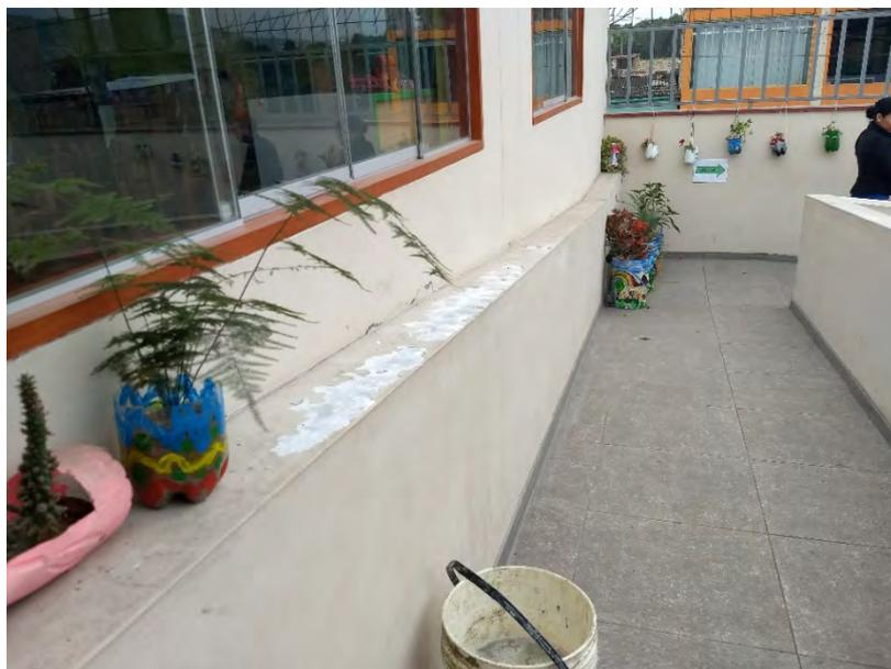
**FOTO N° 03.** En la imagen se muestra la rampa de acceso al Bloque de Aulas de la Institución Educativa Inicial Santa Rosa de Lima, y una grieta longitudinal, en la junta fría formada con el bloque de aulas adenaño.
