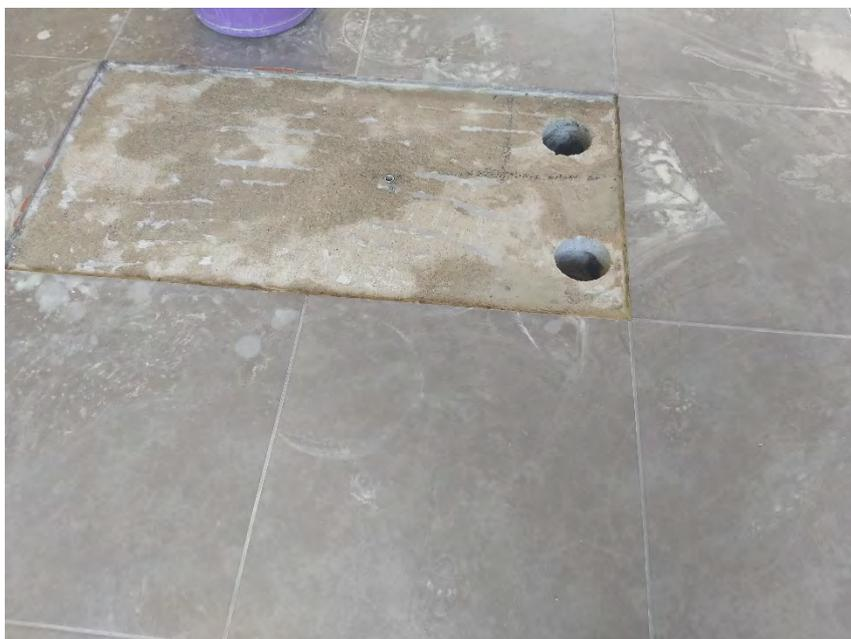
**FOTO N° 29.** En la fotografía se muestran los puntos donde se realizó la extracción de las muestras M7 y M8 referentes a la losa de la edificación en análisis.
