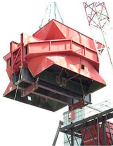
Figura 12 Precalentador de aire regenerativo
