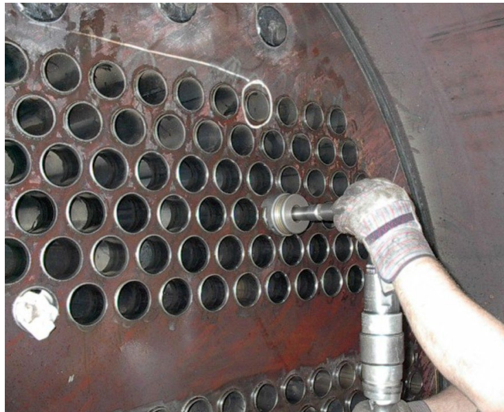
Figura 4 Instalación de tubos de fuego en un generador de vapor pirotubular
