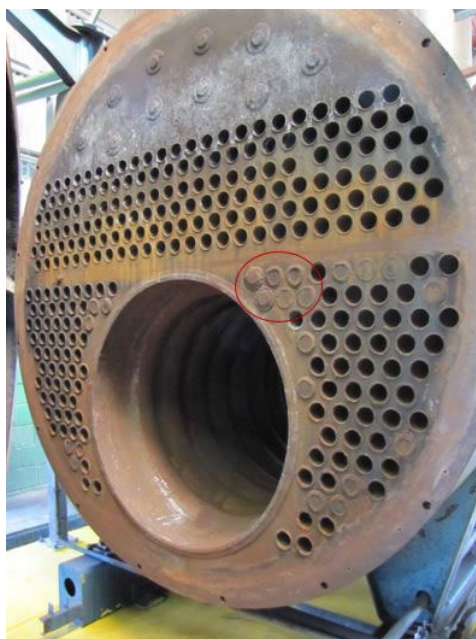
Figura 5 Vista de un espejo de un generador de vapor pirotubular
