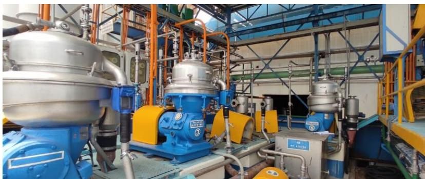
Figura 16. Sala de licores PAMA (separadoras, centrifugas y pulidoras)
