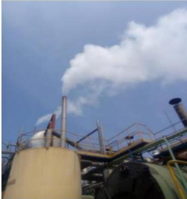
Figura 1. Perdida de vapor flash en el tanque de condensados de copeinca Chimbote
