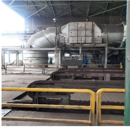
Figura A4: Fotografía del interior de la planta largos.
