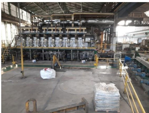
Figura A1: Fotografía del interior de la planta largos.
