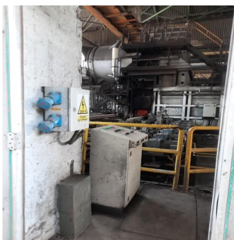
Figura A3: Fotografía del interior de la planta largos.
