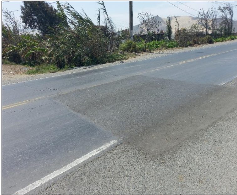
Foto N° 29: Reparación o “parche” de pavimento
