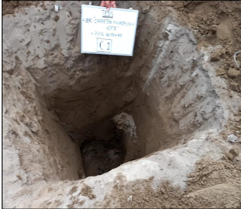
Foto N° 07: Excavación para la C-1, h =1.50m (Referencia: Chimbote)
