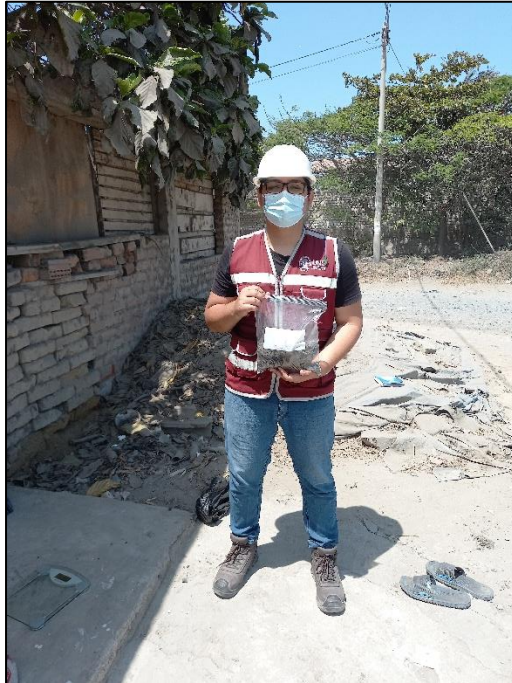
Foto N° 13: Tomas de muestra para el ensayo de contenido de humedad
