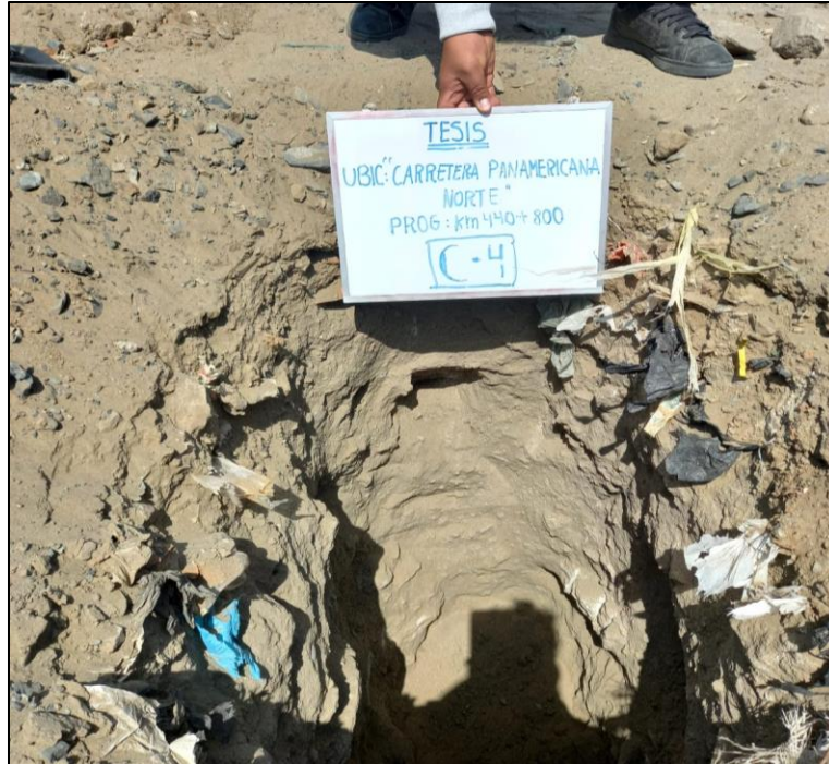
Foto N° 10 : Excavación para la C-4, h =1.50m (Referencia: Chimbote )
