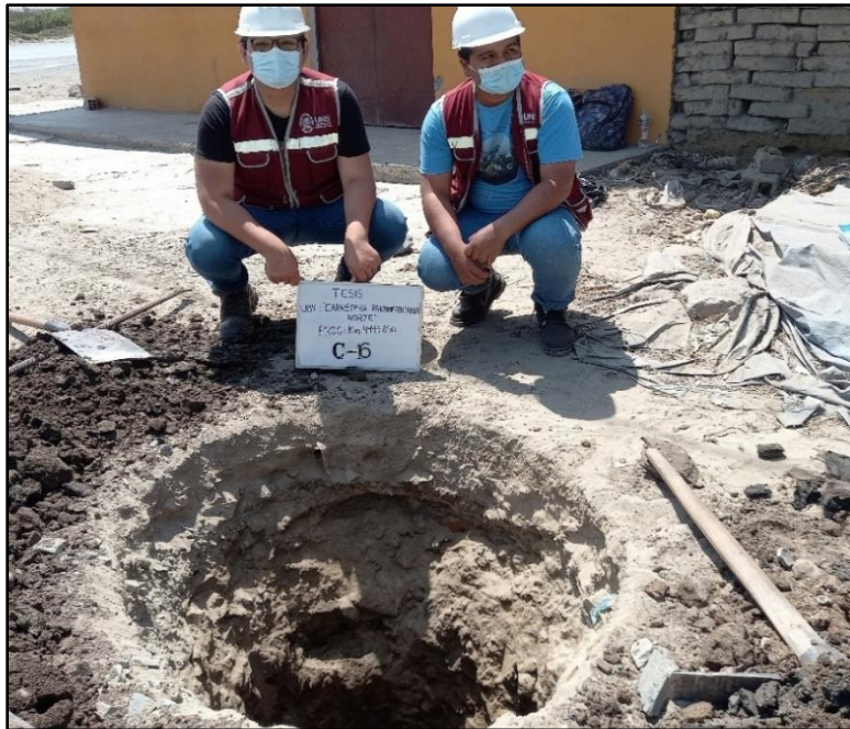
Foto N° 12 : Excavación para la C-06, h =1.50m (Referencia: Santa)
