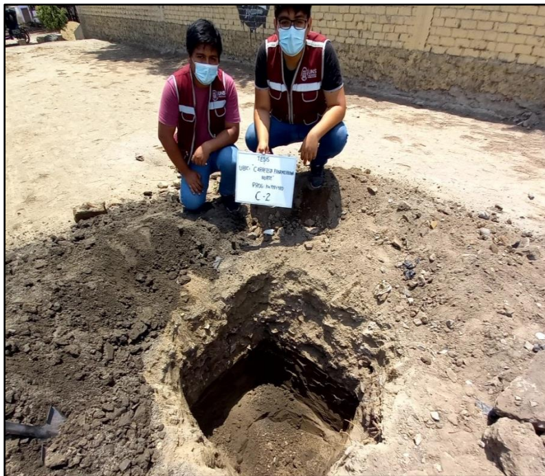
Foto N° 08 : Excavación para la C-02, h =1.50m (Referencia: Santa )
