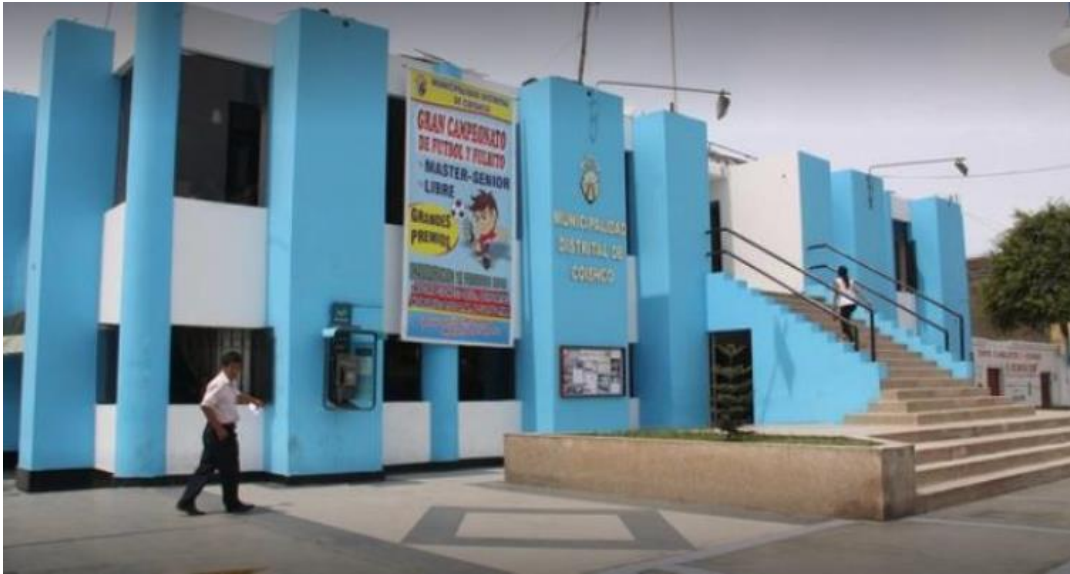
Figura N° 01: Municipalidad del Distrito de Coishco Fuente: Portal de Transparencia de la Municipalidad Distrital de Coishco
