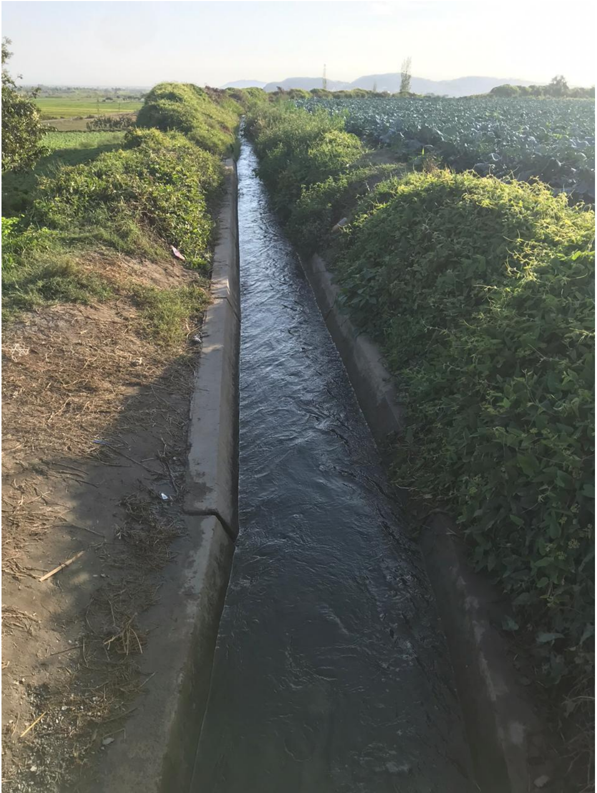
Figura A1. Tramo del Canal Alto, punto 1.
