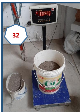
Fotografías N° 32 y 33: Arena para la tanda y mezclado empezando con piedra y agua.
