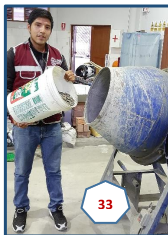
Fotografías N° 32 y 33: Arena para la tanda y mezclado empezando con piedra y agua.
