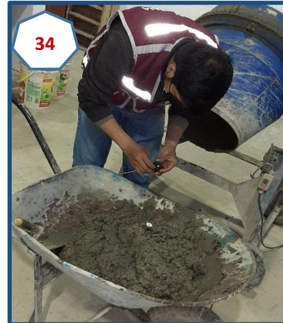
Fotografía N° 34: Bachada de la tanda y toma de temperatura del concreto.
