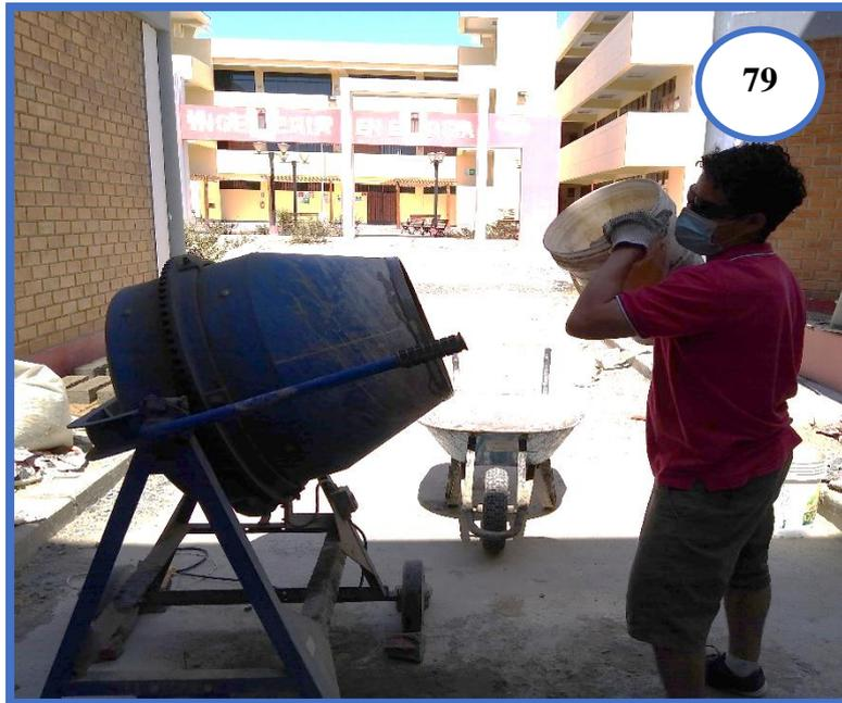
**Fotografía N°79:** Vaciando el agregado fino a la mezcladora, luego se agrega el cemento y se termina de verter el agua restante.
