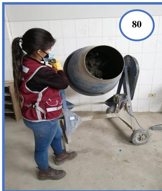
**Fotografía N°80:** Mezclándose todos los materiales para la elaboración de la mezcla de concreto.
