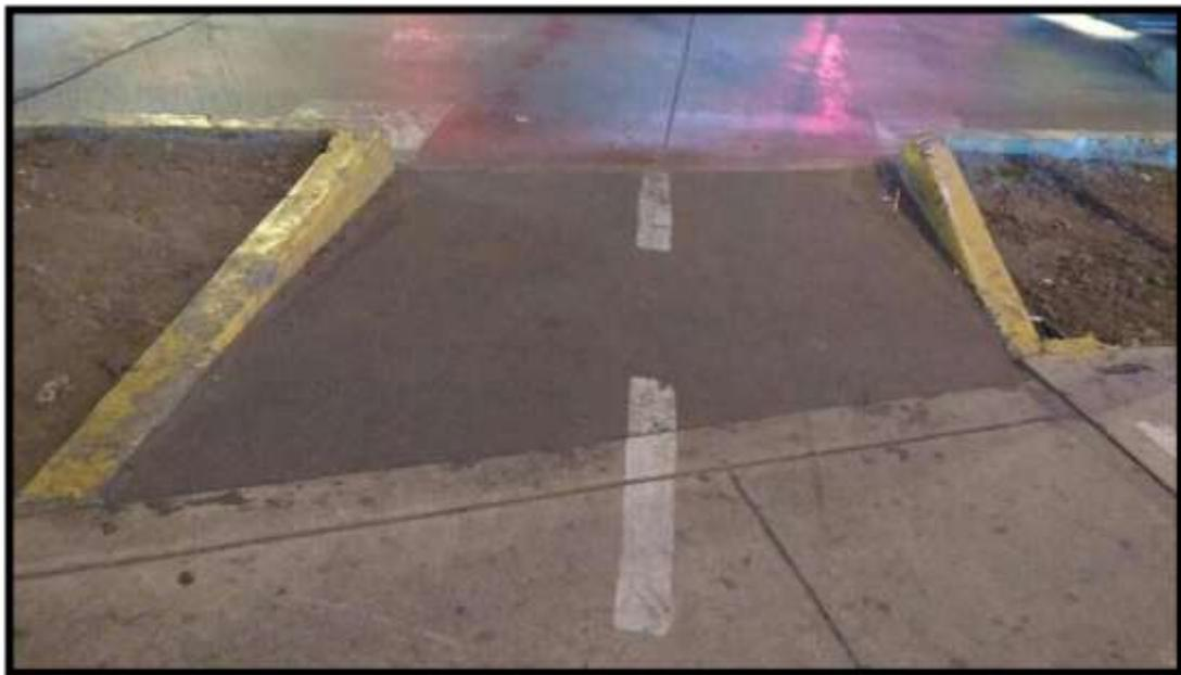
**Foto N°56:** Se observa como adaptaron una berma con un desnivel de 10 cm, colocando una rampa de asfalto.
