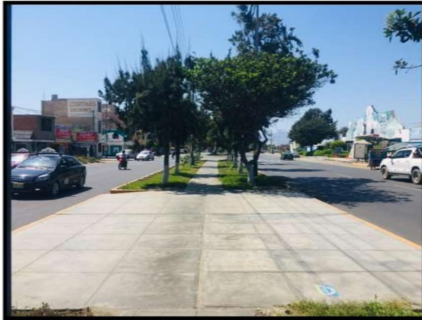
**Foto N°05:** Falta de rampas en la berma central en la Avenida Pacífico.
