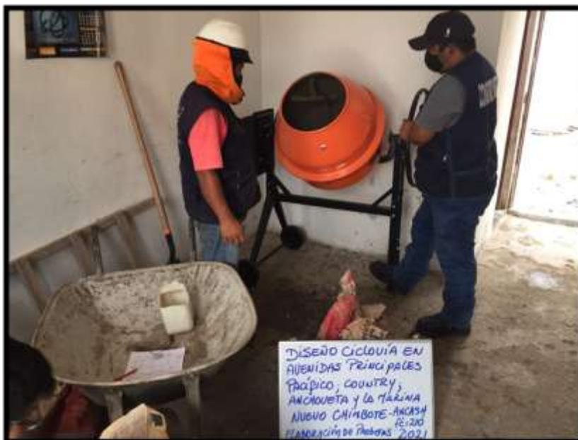
**Foto N°46:** Mezcla de los agregados, agua y cemento para la obtención de concreto.
