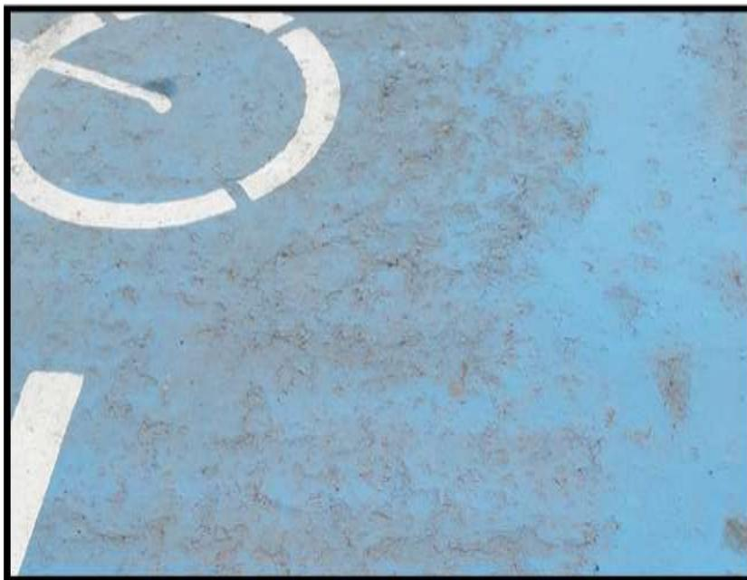
**Foto N°14:** Se muestra el estado actual de la pintura colocada en el pavimento de la ciclovia.
