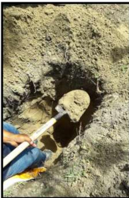
**Foto N°26:** Excavación de la calicata C-03 en la Avenida Pacífico.
