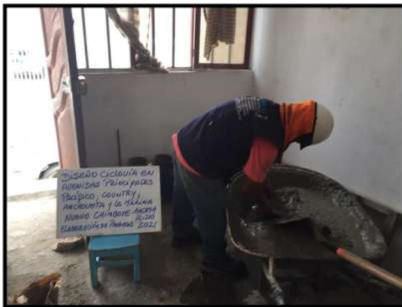
**Foto N°47:** Se muestra la obtención de concreto  $F'c=210$  kg/cm<sup>2</sup>.
