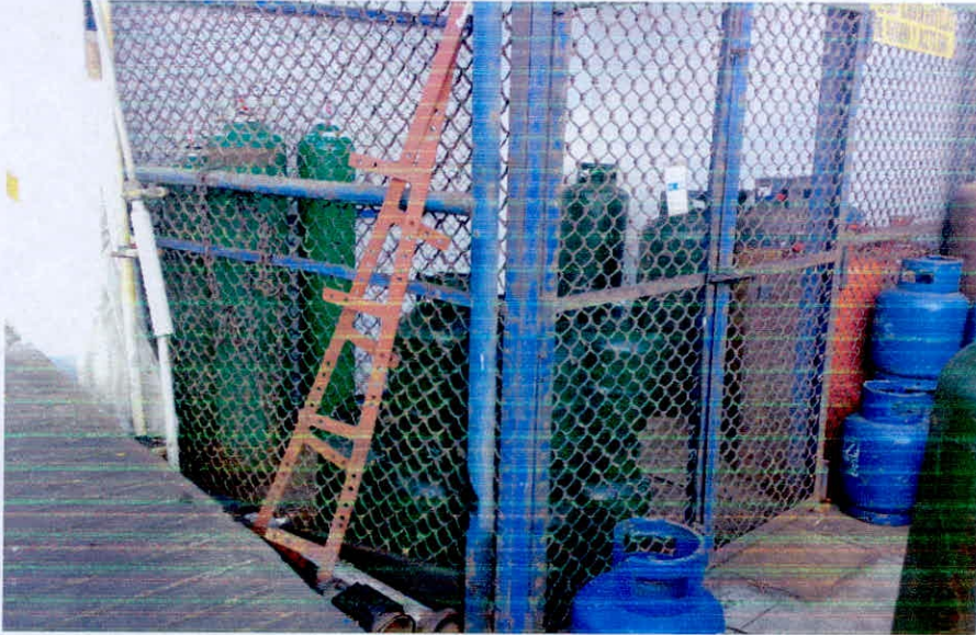
Foto 9: Almacén de materiales para soldadura (oxígeno, acetileno)
