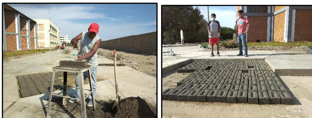
**FOTOGRAFIA N°28:** Se procedió al moldeado de las unidades de concreto y luego al tendido de las unidades de albañilería.
