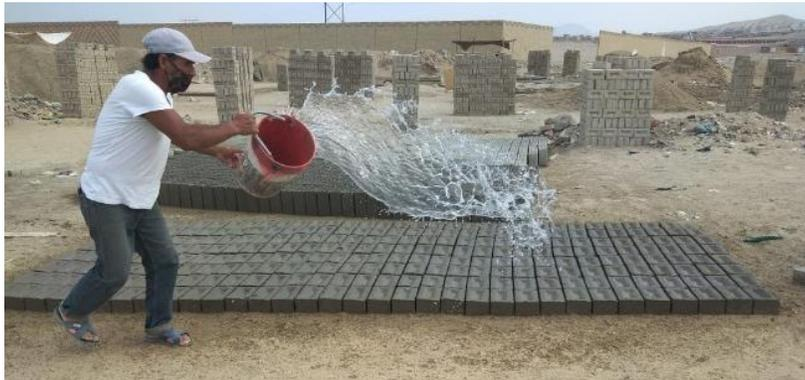
**Figura 12.** *Curado de los ladrillos*
