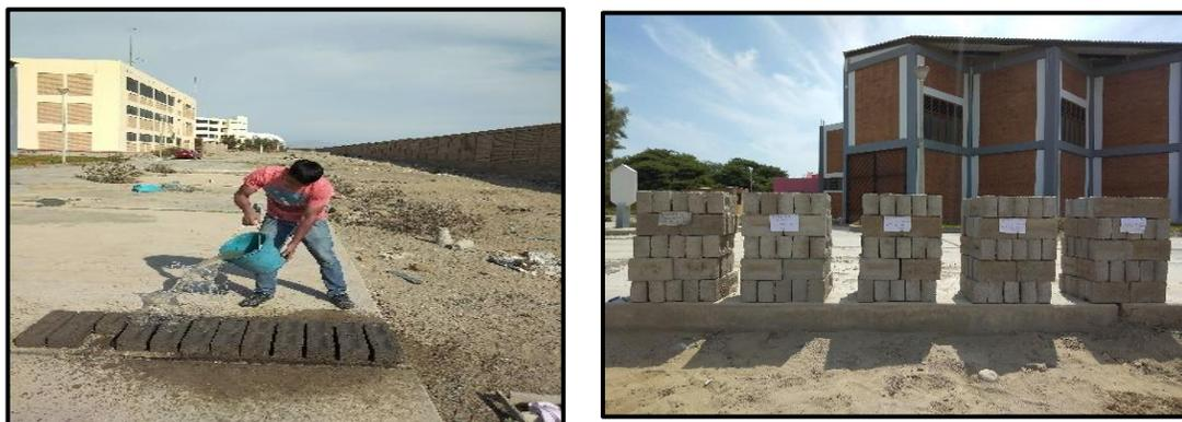
**FOTOGRAFIA N°29:** Las unidades de albañilería se curaron por 28 días como indica en la Norma E-070.
