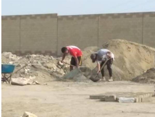
**Figura 07.** *Mezclado de los componentes del ladrillo en seco*
