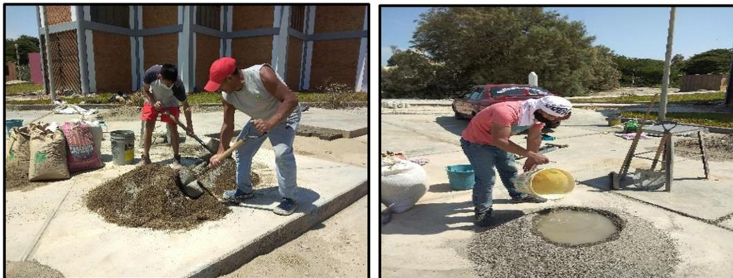
**FOTOGRAFIA N°27:** Se prepararon los agregados de acuerdo a una dosificación y luego se preparó la mezcla como se muestra en la imagen.
