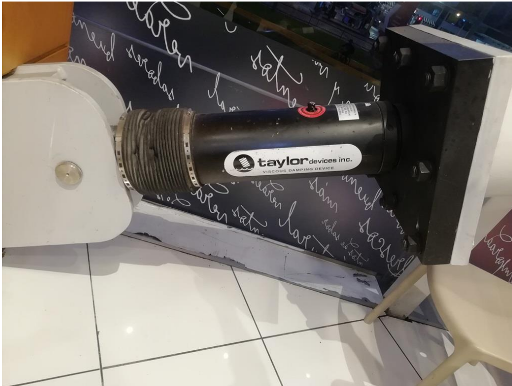
DISIPADOR DE FLUIDO VISCOSO – CENTRO COMERCIAL METRO LIMA
