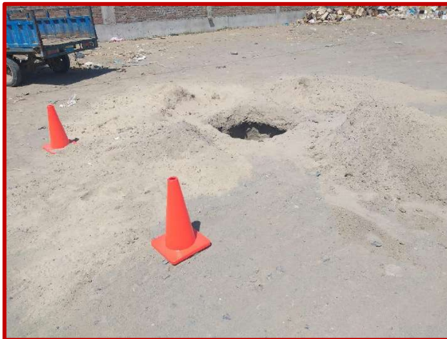
Figura N°05: señalización en calicata N°01.
