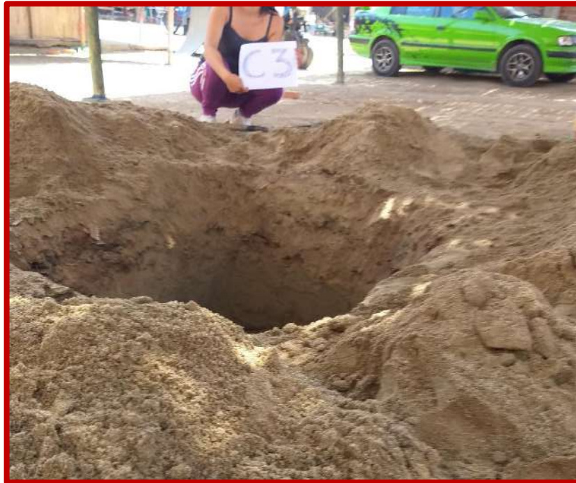
Figura N°09: excavación y toma de muestra en la calicata N°03
