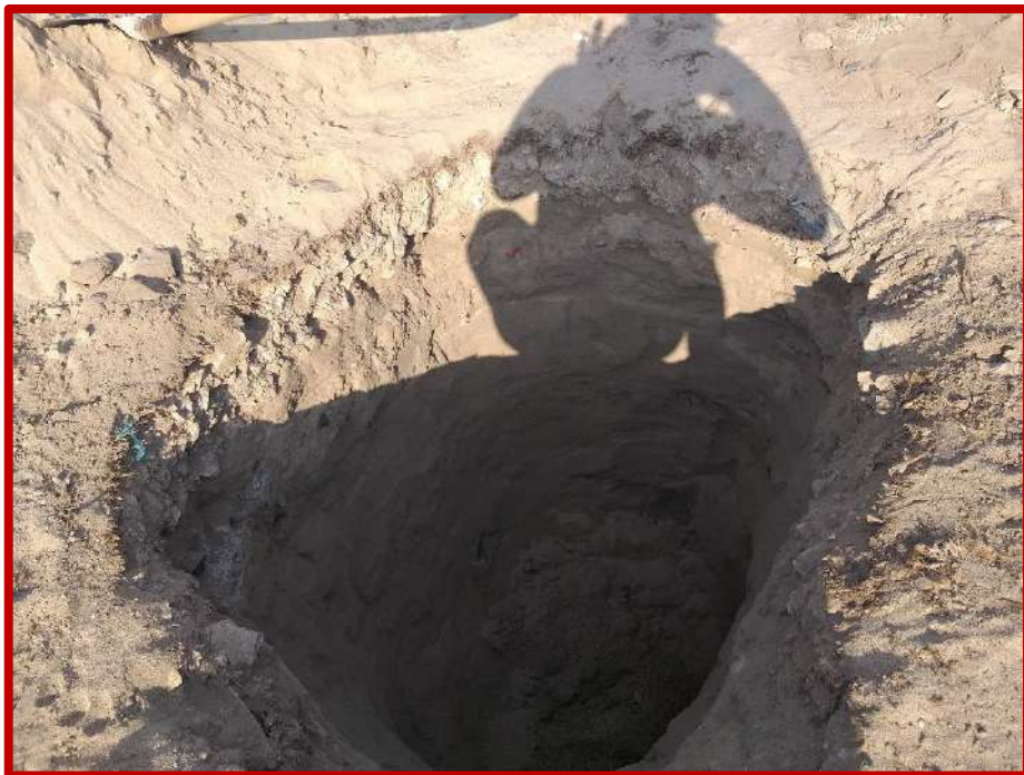
Figura N°08: calicata N°02 con profundidad de 1.50m
