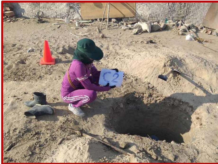
Figura N°07: excavación y toma de muestra en la calicata N°02
