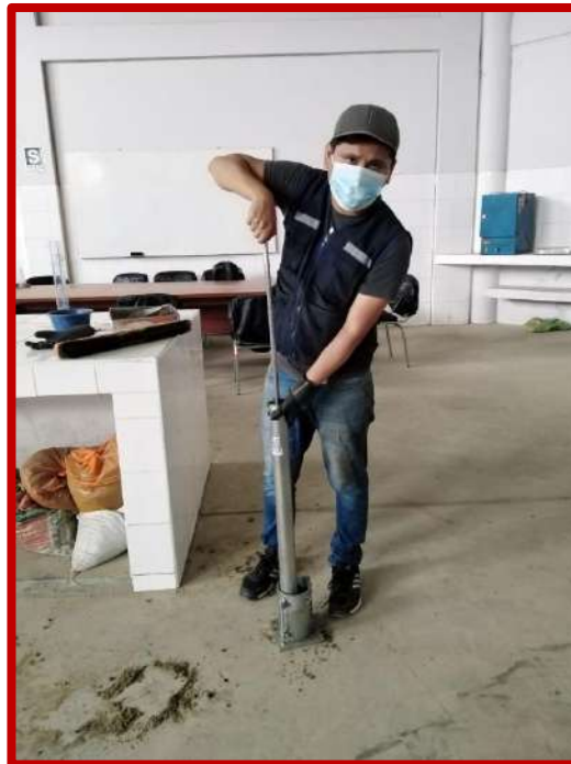
Figura N°54: compactación del suelo en 5 capas, haciendo uso del pisón manual
