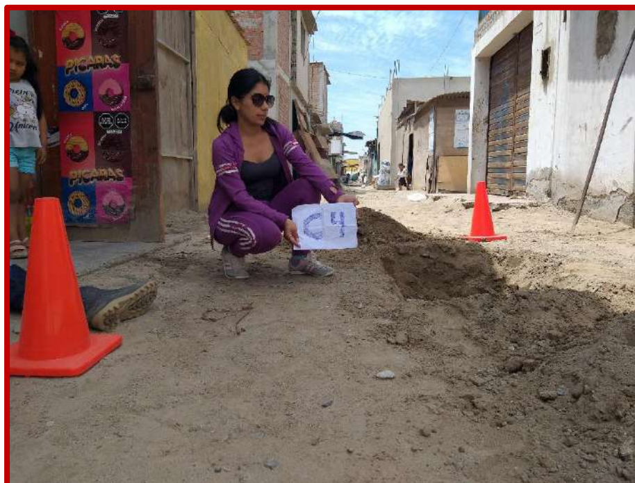
Figura N°12: excavación y toma de muestra en la calicata N°04
