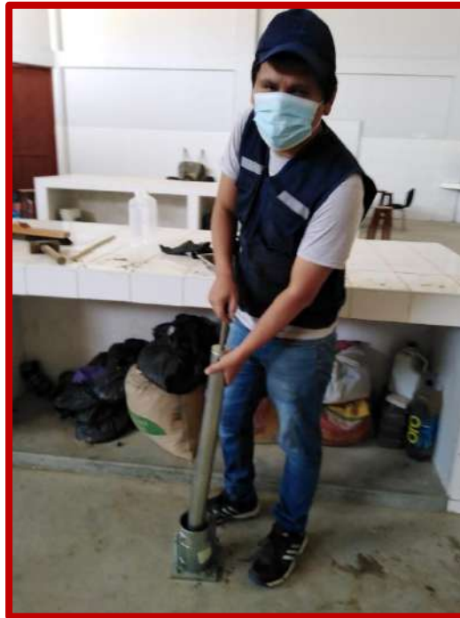
Figura N°49: compactación del suelo en 5 capas, haciendo uso del pisón manual
