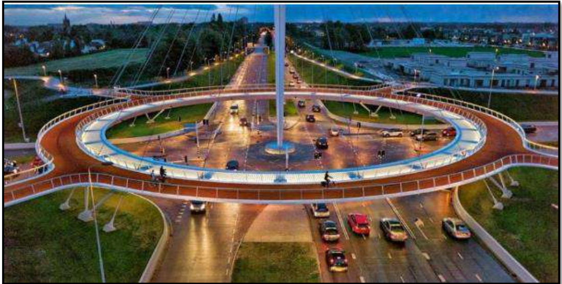
FIGURA 12. Estructura de la rotonda colgante “Hovenring”.
