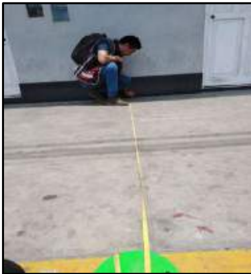
Fotografía N°69-70: Realización de la toma de medidas de cada elemento que forma parte de la sección transversal de la Av. Aviación, para la posterior configuración, adecuando a la ciclovia en su espacio.
