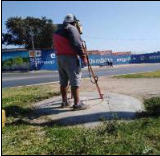
Fotografía N°35-36: Realización del levantamiento topográfico para el diseño del puente bici-peatonal en la E-1, ubicado en la Av. Industrial, parte Este del Ov. San Pedro en la Ciudad de Chimbote.
