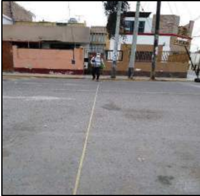
Fotografía N°43-44: Realización de la toma de medidas de cada elemento que forma parte de la sección transversal del Jr. Enrique Palacios, para la posterior configuración, adecuando a la cicloavía en su espacio.
