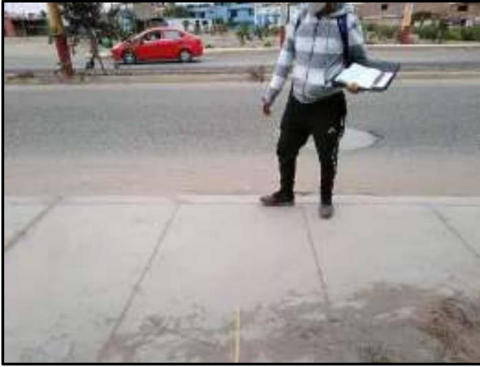
Fotografía N°51-52: Realización de la toma de medidas de cada elemento que forma parte de la sección transversal de la Av. Laderas del Norte, para la posterior configuración, adecuando a la cicloavía en su espacio.
