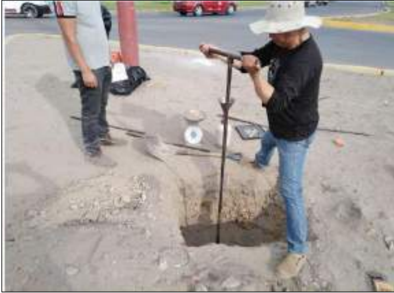
Fotografía N°01-02: Excavación y recojo de muestras de suelo con el muestreador manual y palana de las calicatas en el Ov. San Pedro.
