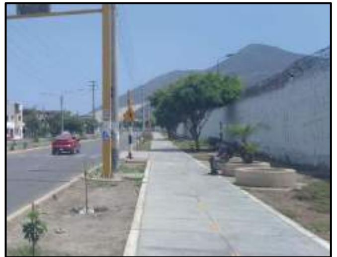
Fotografía N°92: Estación ubicada en la intersección entre la Av. Industrial y el Jr. Enrique Palacios en la Ciudad de Chimbote.
