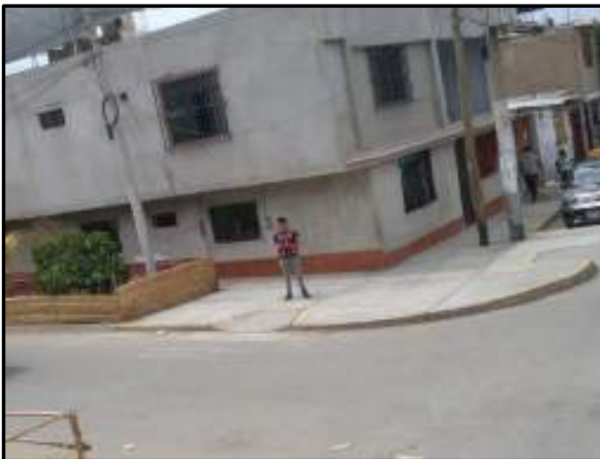
Fotografía N°89: Estación ubicada en la intersección entre el Jr. Jorge Chávez y el Jr. Arequipa en la Ciudad de Chimbo.
