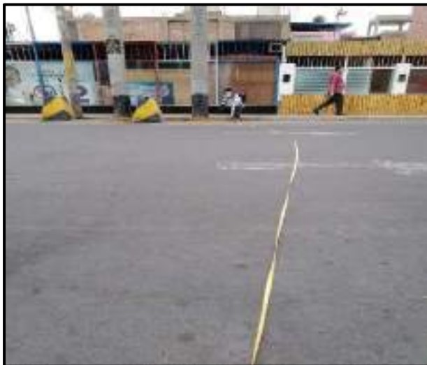
Fotografía N°41-42: Realización de la toma de medidas de cada elemento que forma parte de la sección transversal del Jr. Carlos de los Heros, para la posterior configuración, adecuando a la ciclovia en su espacio.
